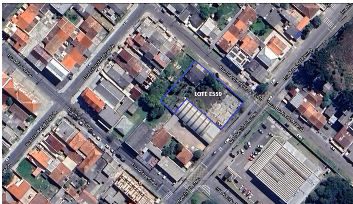
Figura 7: Foto aérea do Lote E559 no ano de 2026. (Fonte: Google)
