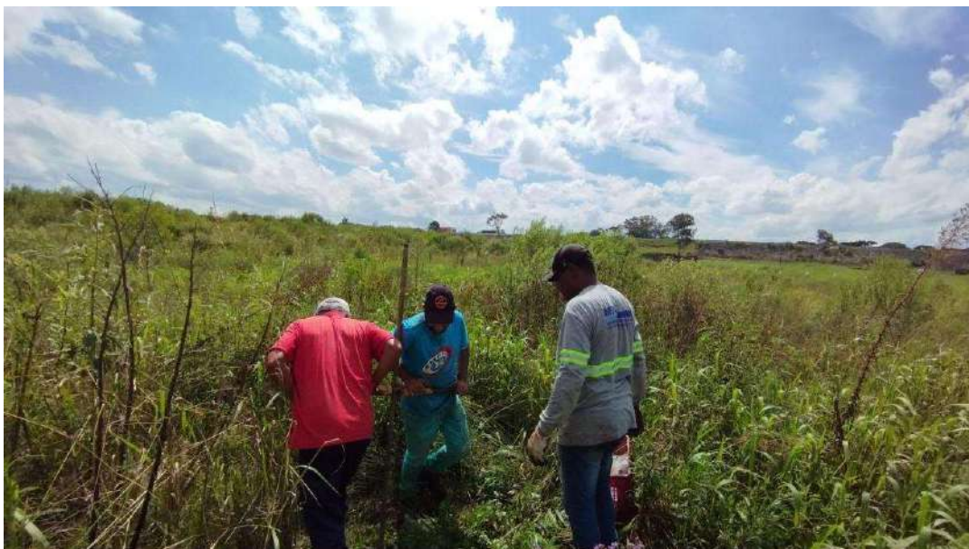
Realização de sondagem à trado manual. Marginal da BR-116 ao fundo.
