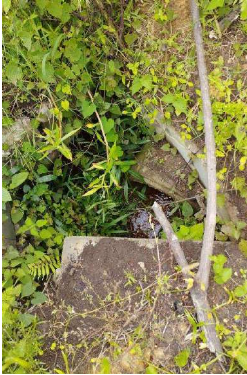
Estruturas de concreto (tubulação) com água corrente, próximo à superfície.
