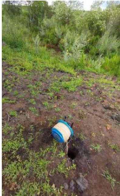
Medição de nível da água na sondagem ST-11, próximo à acúmulo de água superficial.
