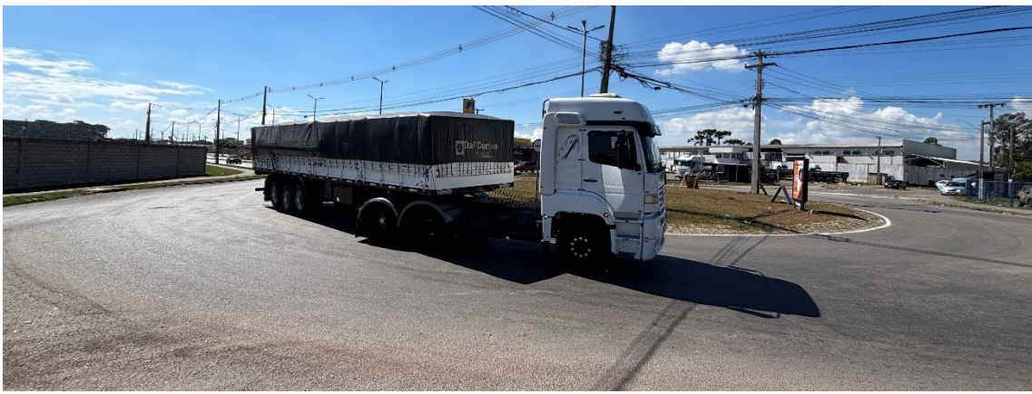
Rotunda no cruzamento entre Avenida Rui Barbosa com Rua Salomão Nasser – capacidade de tráfego
