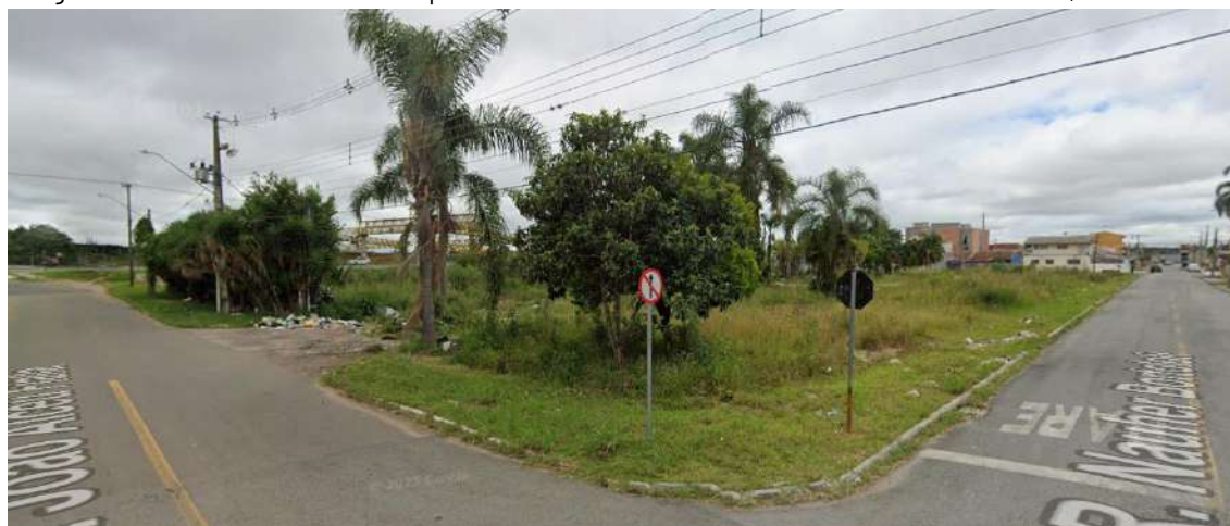
Figura 8. Testada do terreno na esquina entre a R. João Alceu Fialla e a R. Nauher Bortolotti, ano de 2024
