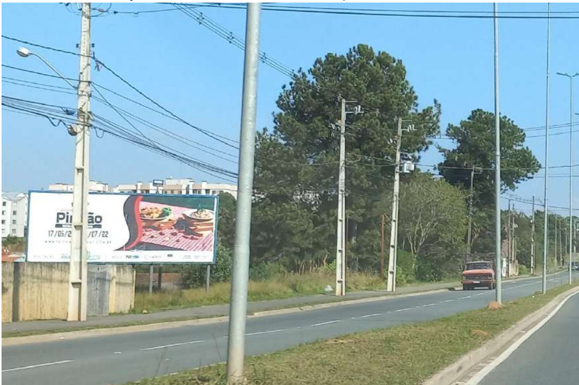
Figura 8. Testada do terreno com frente para a Av. Rui Barbosa
