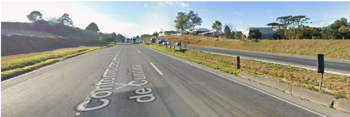
Figura 36. Rodovia Federal BR-116, via de distribuição
