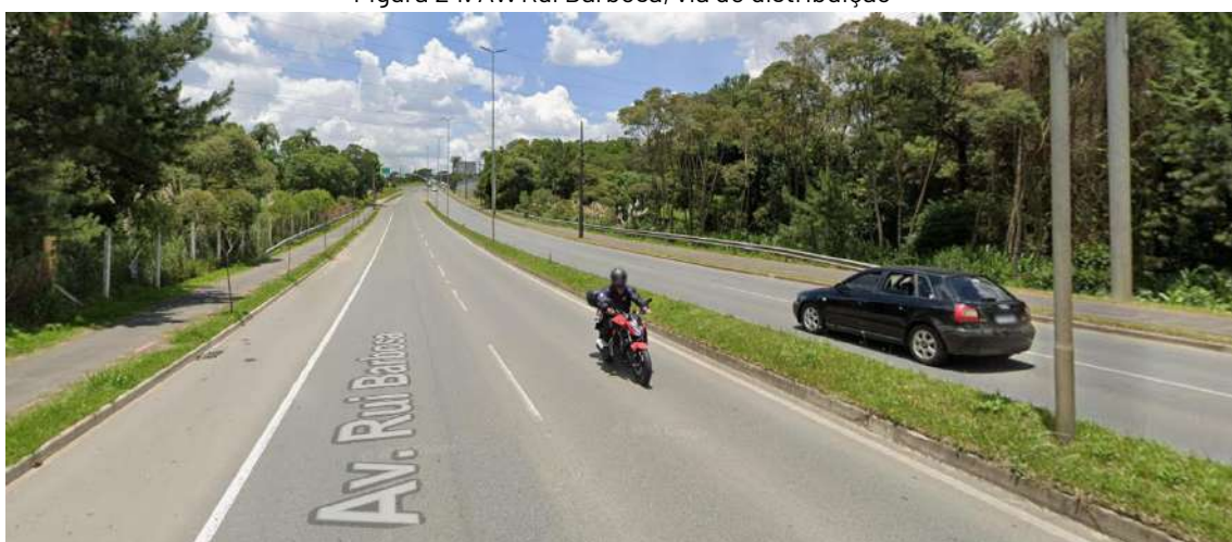
Figura 24. Av. Rui Barbosa, via de distribuição
