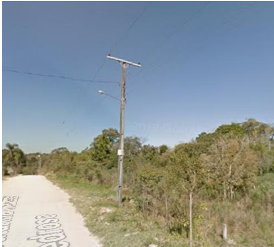
FIGURA 5 - POSTE DE ENERGIA AO LONGO DA RUA CATARINA M. PEDROSO
