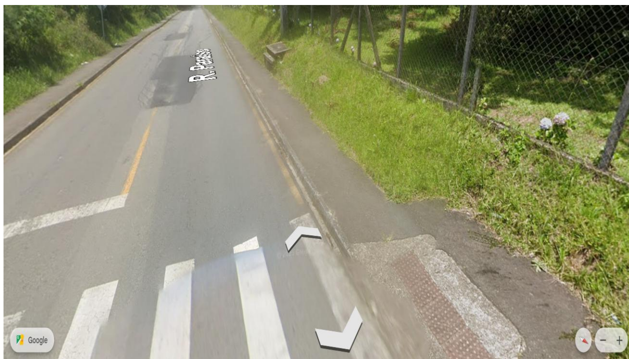
Figura XXII - Rampa de acesso de cadeirantes na R. Paraíso
