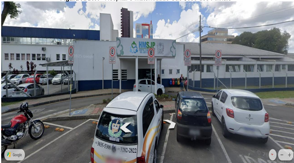
Figura XXXVI - Hospital e Maternidade São José dos Pinhais
