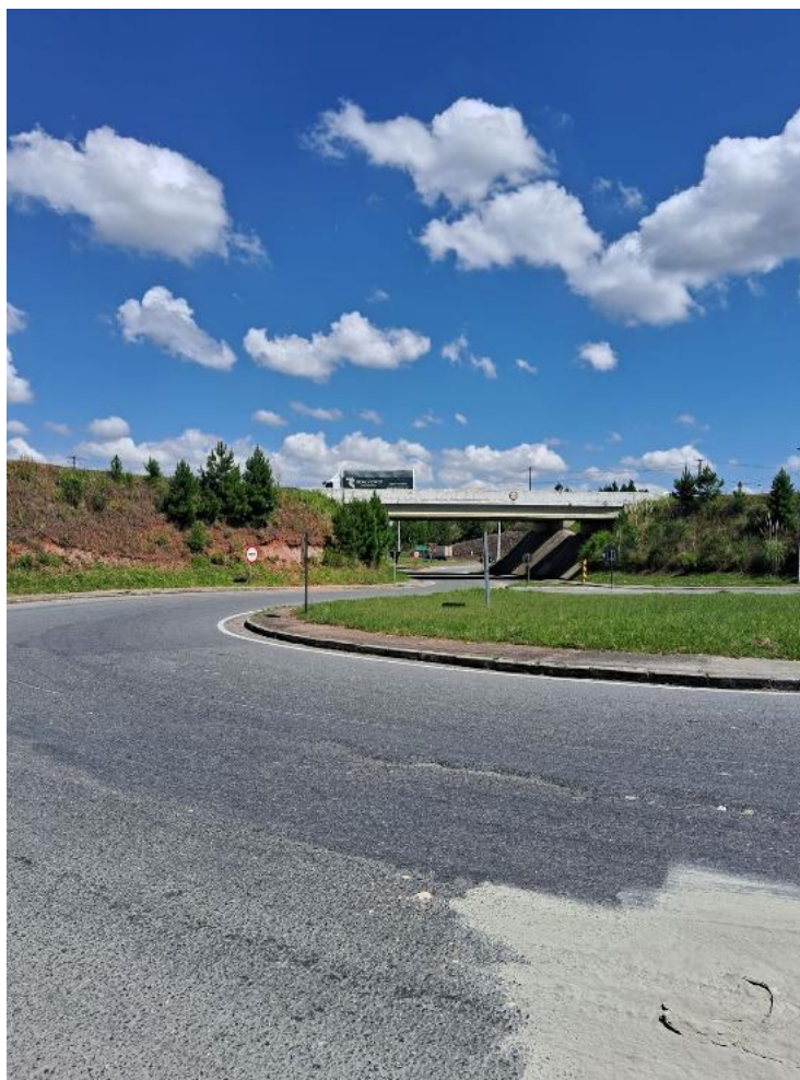
Figura 25 – Viaduto e rotatorio de acesso a Br 376.
