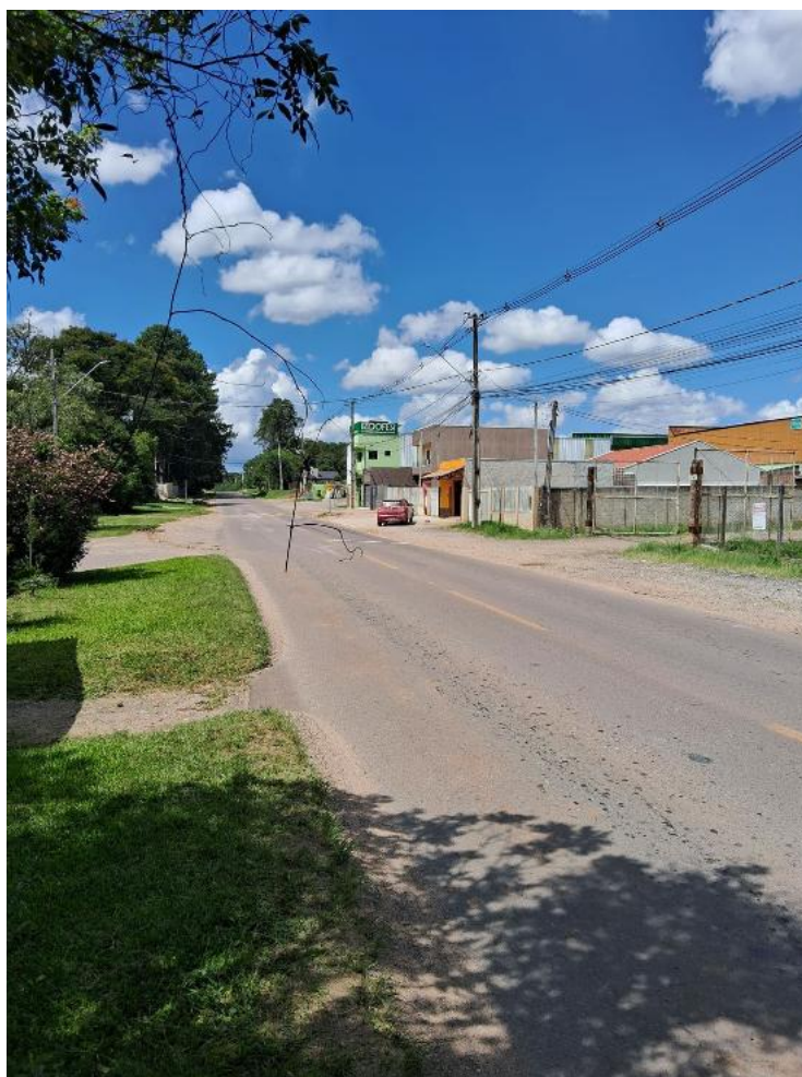
Figura 21 – Acesso da Rua Francisco Proft, Pela Rua Antonio Singer, antes do Contorno Leste de Curitiba
