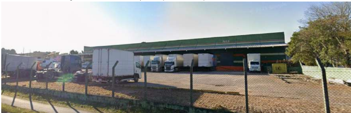
Figura 17. Atividade de prestação de serviço na Avenida Rui Barbosa
