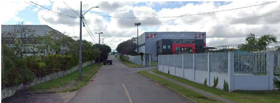
Figura 19. R. Carlos Gusso, em trecho defronte o lote do empreendimento
