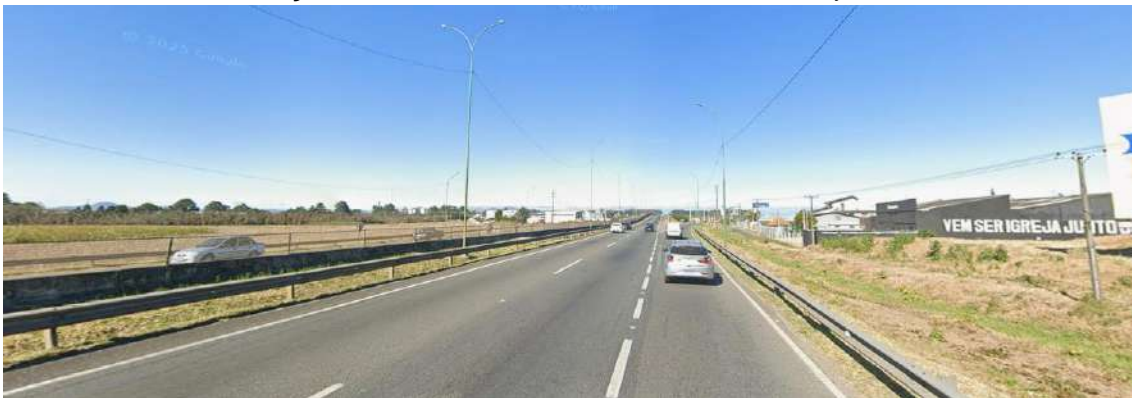
Figura 31. Rodovia Federal BR-277, via de distribuição
