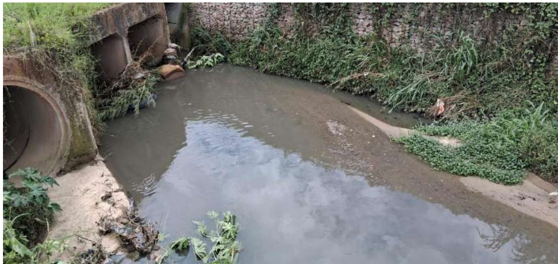
Figura 9 – Manilha que corta a Avenida Rui Barbosa
