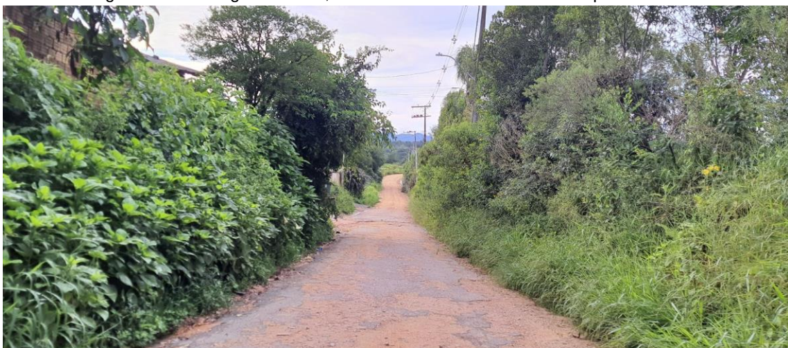
Figura 23. Rua Miguel Zeteski, em trecho defronte ao lote do empreendimento
