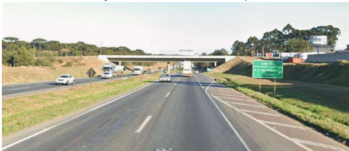
Figura 18. Rod. Federal BR-116, via de distribuição
