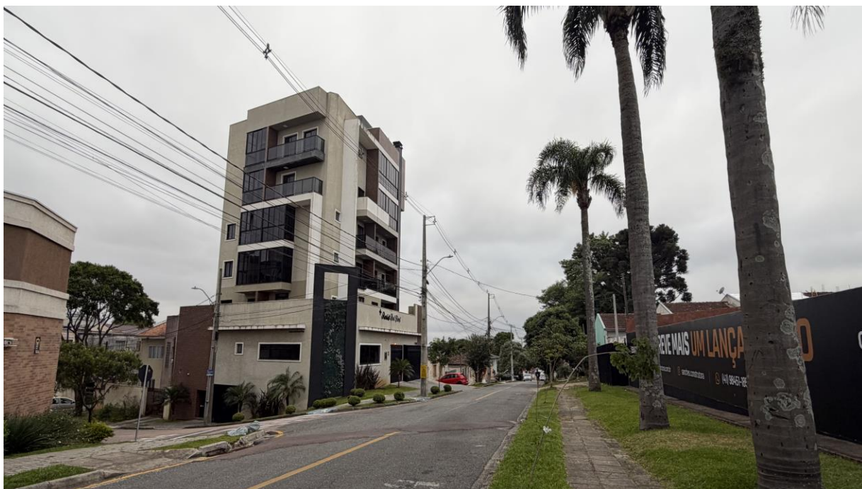
Figura 15: Vista do Condomínio Residencial localizado em frente a testada do imóvel do novo Empreendimento, situado na Rua Clemente Zétola esquina com a Rua Francisco Cassiano de Miranda. (Fonte: Autor/2025)
