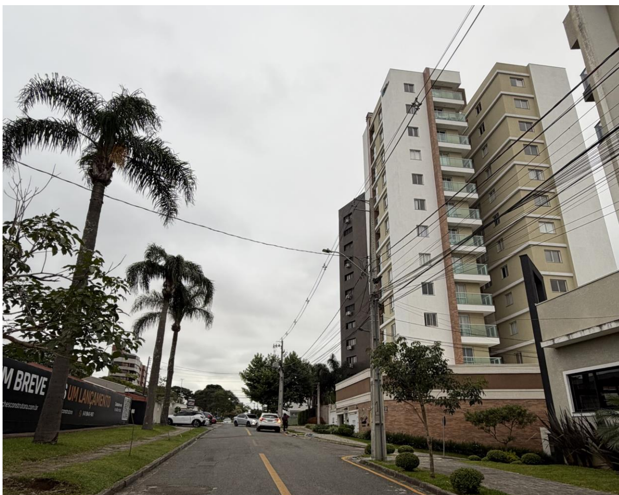
Figura 16: Imagem de outros edifícios residenciais situados na Rua Clemente Zétola, em frente ao novo Condomínio e na esquina com a Rua Francisco Cassiano de Miranda. (Fonte: Autor/2025)
