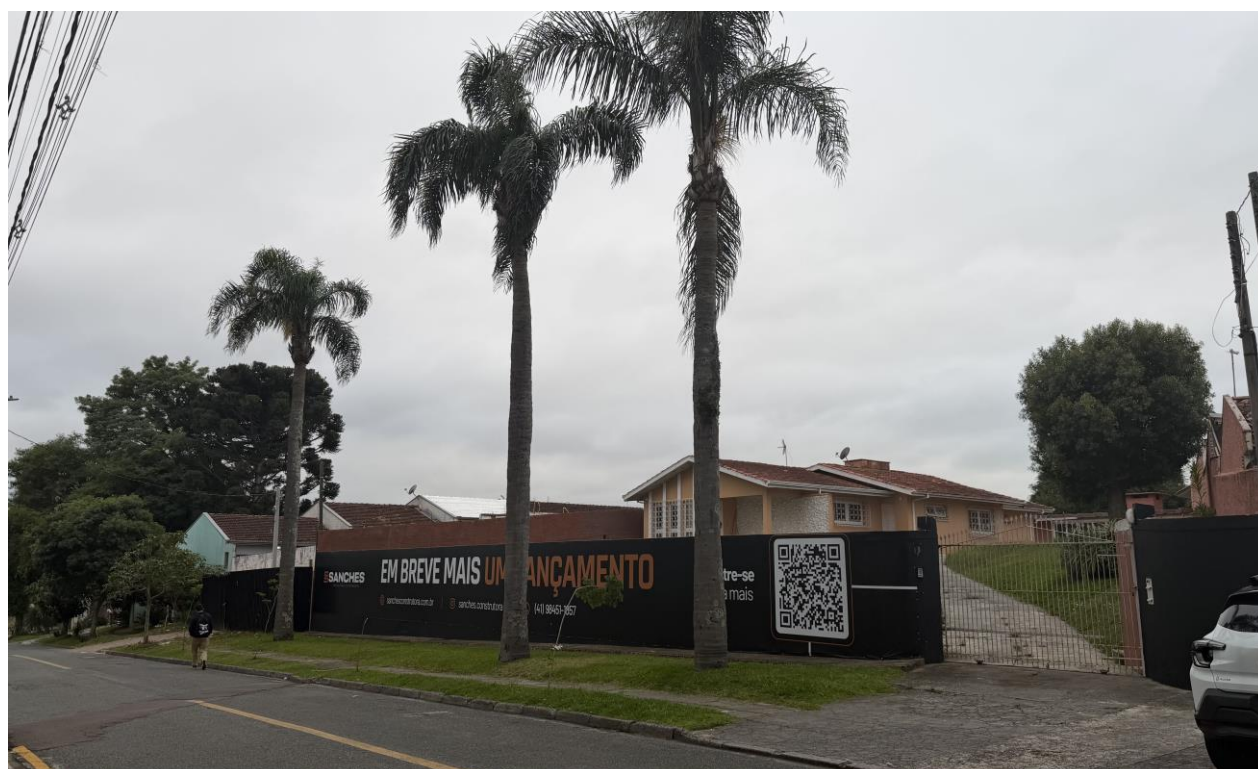
Figura 2: Vista da testada frontal do terreno que será implantado o novo Condomínio na Rua Clemente Zetola 315. (Fonte: Autor/2025).
