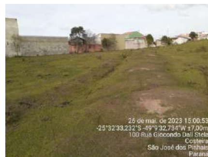
Figura 17 – Canais artificiais executados para escoamento das águas pluviais das ruas a montante do empreendimento
