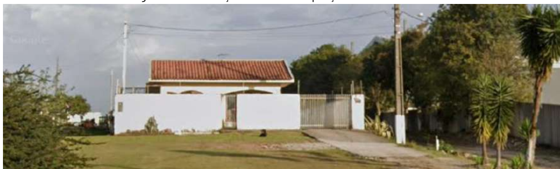
Figura 12. Construção existente na porção oeste do terreno
