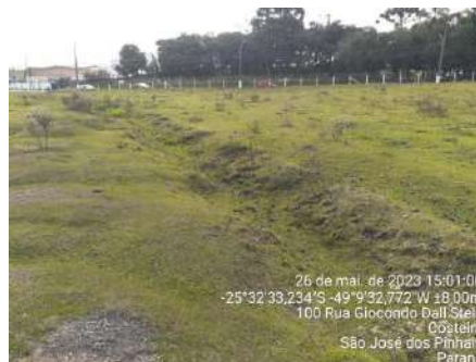
Figura 21 - Canais artificiais executados para escoamento das águas pluviais das ruas a leste da área
