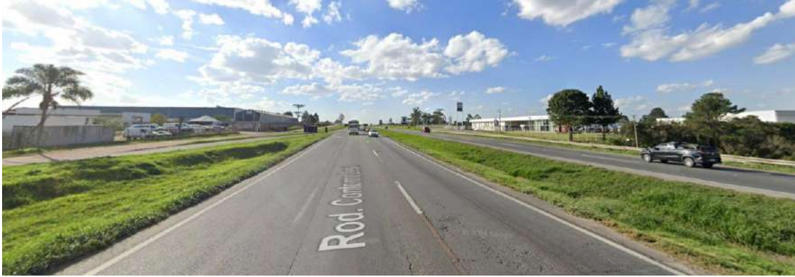
Figura 25. Rod. Federal BR-116, via de distribuição
