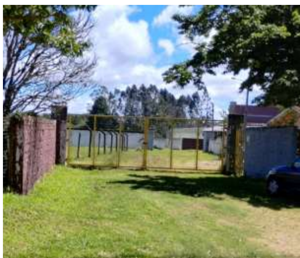
Foto 01 – Portão de acesso.
