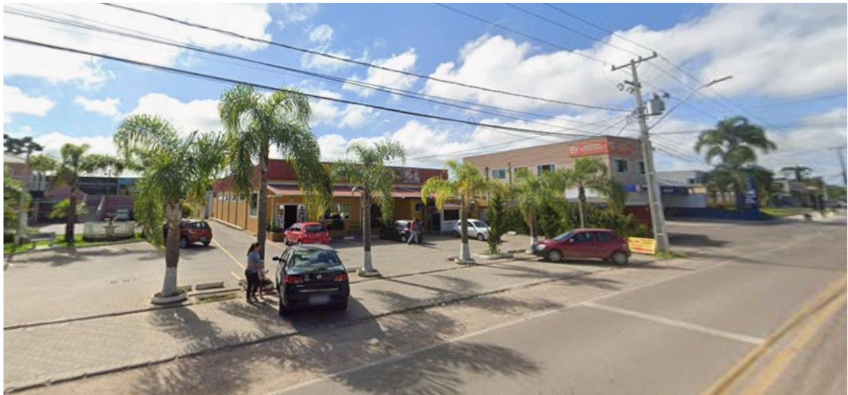
Figura 27: Fachada de Comércio e Serviços como Mercado Helen, Farmácia Pix e Academia existentes na Rua Antonio Singer e distantes 650,00m aproximadamente do novo Empreendimento.
