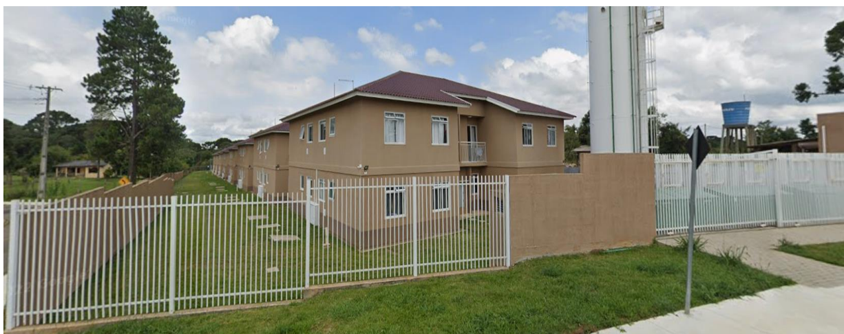
Figura 22: Vista do Residencial Safira que se encontra a 35,00m do novo Empreendimento, estando implantado parcialmente e o restante em fase de construção.
