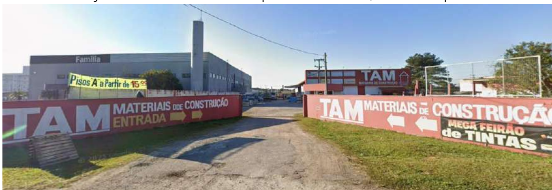
Figura 11. Acesso atual ao terreno pela Av. Rui Barbosa, na lateral esquerda
