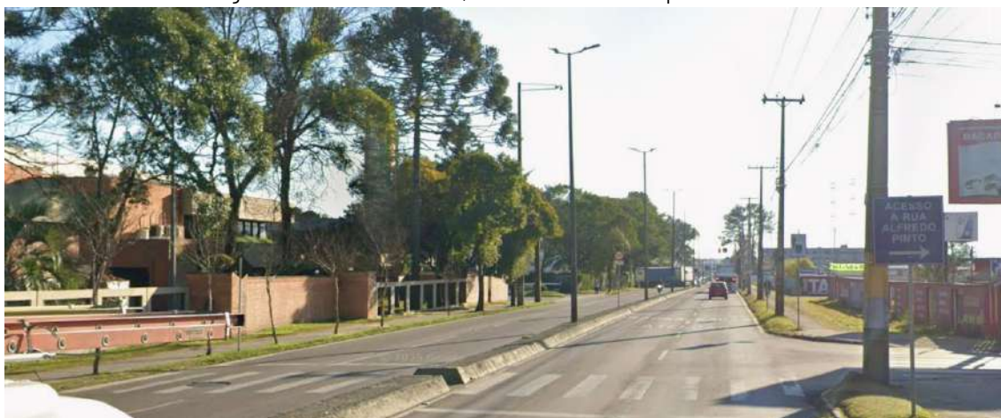
Figura 28. Av. Rui Barbosa, via de acesso ao empreendimento
