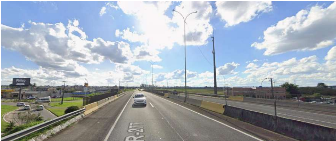
Figura 31. Rod. Federal BR-277, via de distribuição
