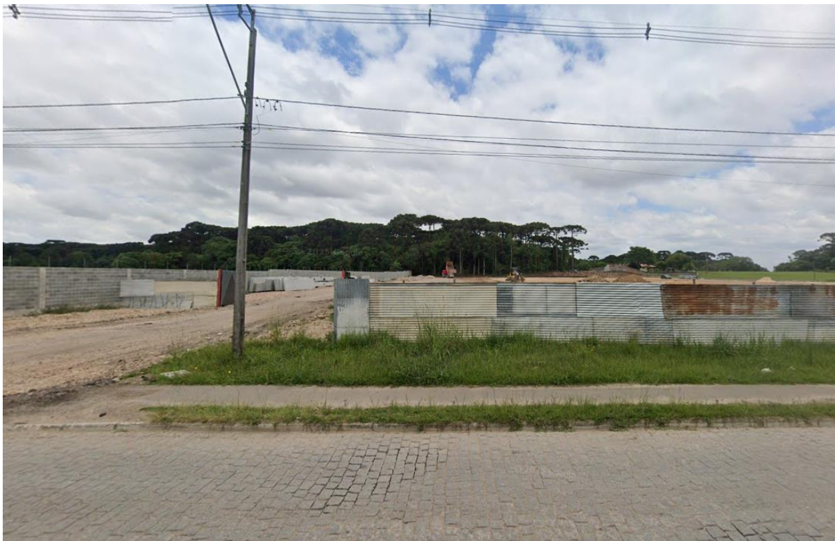
Figura 2 – Vista frontal do Empreendimento a partir do acesso junto à Rua Joroslau Sochaki.
