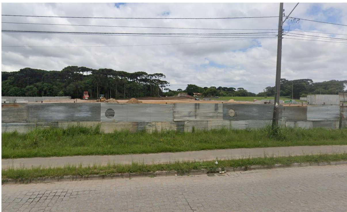
Figura 7 – Vista Frente Imóvel pela Rua Joroslau Sochaki.
