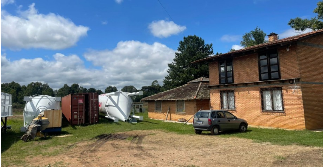
Figura 15. Porção interna do imóvel – construções existentes a serem demolidas.
