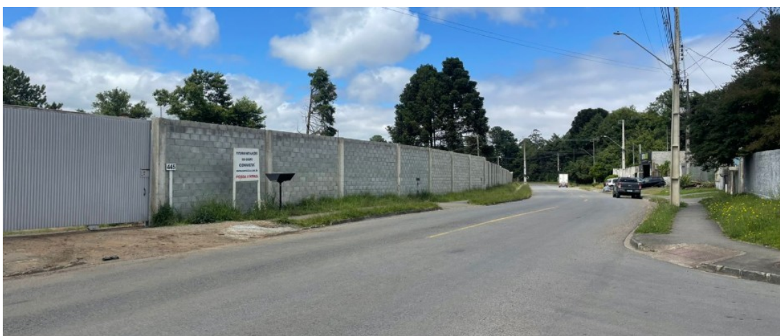
Figura 11. Testada atual do terreno com frente para a Rua Sebastiana Santana Fraga, ano de 2025.
