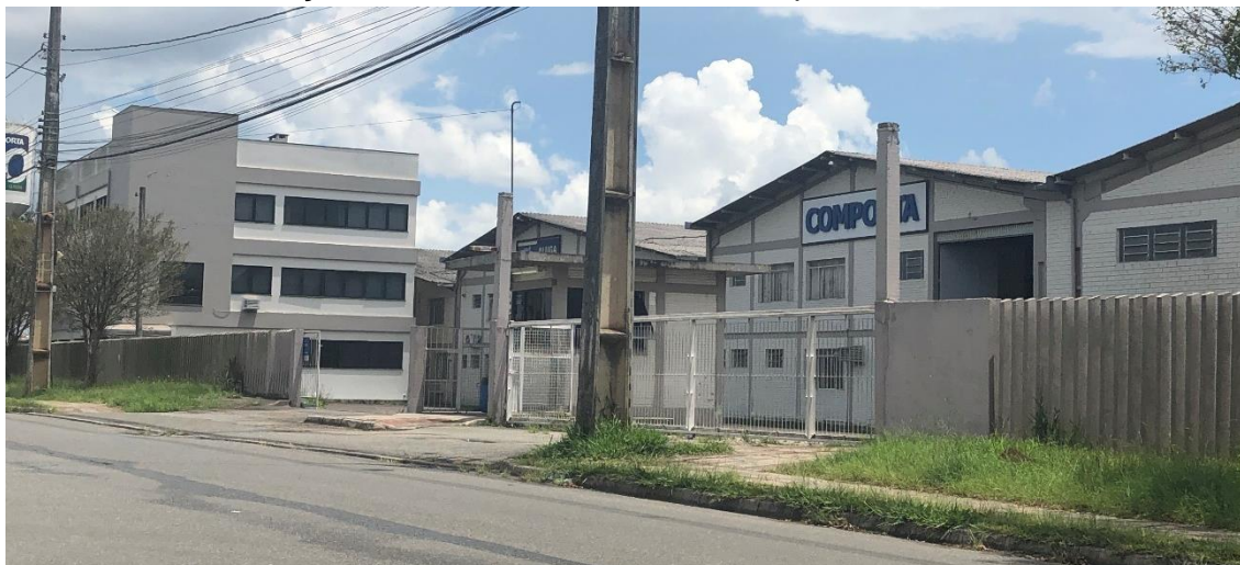
Figura 12. Parte frontal do terreno: construções existentes
