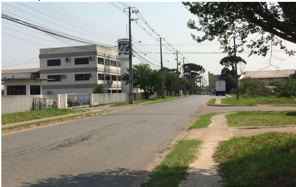
Figura 19. Rua São Salvador, em trecho defronte ao futuro lote do empreendimento
