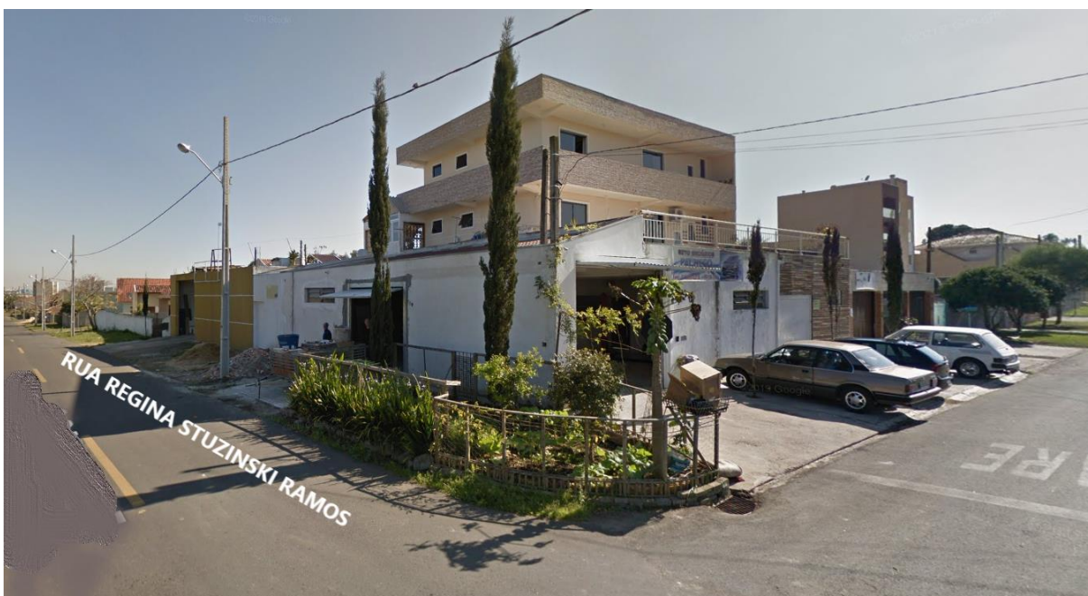
Figura 17: Vista de edificações residenciais implantadas em frente ao Empreendimento, no Loteamento São Francisco, que excedem os parâmetros urbanísticos do zoneamento local.
