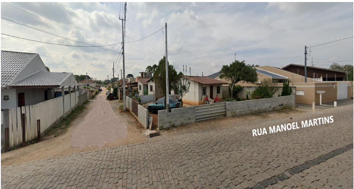
Figura 23: Vista de Residências em ocupações irregulares localizadas na Rua Manoel Martins.
