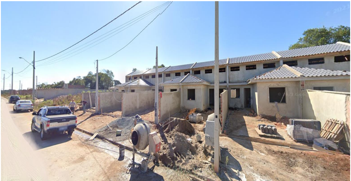
Figura 22: Vista de residências em construção no Loteamento Recanto San José, situado também na Rua Manoel Martins.
