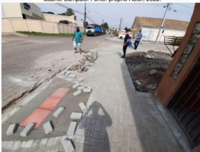
Foto 04 – Rampa de acessibilidade na esquina das ruas Antonio Sitone e Henrique Gonzaga de Souza Neto. Fonte: próprio Autor, 2023.
