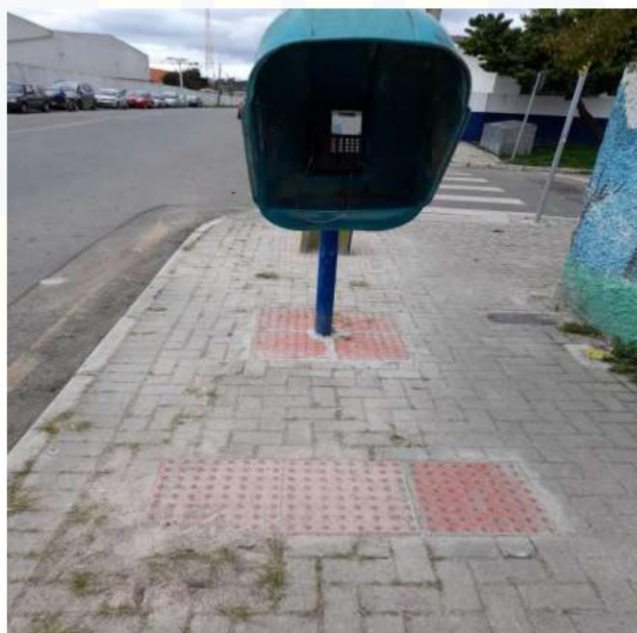
Foto 17 – Piso tátil de alerta em telefone público, localizado na Rua Henrique Gonzaga de Souza Neto. Fonte: próprio Autor, 2022.
