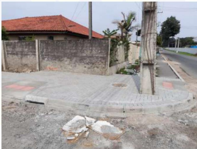
Figura 02 – Rampa de acessibilidade na esquina das ruas Antonio Sitone e Henrique Gonzaga de Souza Neto. Fonte: próprio Autor, 2022
