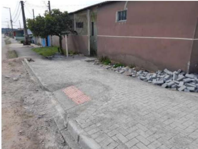
Figura 01 – Rampa de acessibilidade na esquina das ruas Antonio Sitone e Henrique Gonzaga de Souza Neto. Fonte: próprio Autor, 2022.
