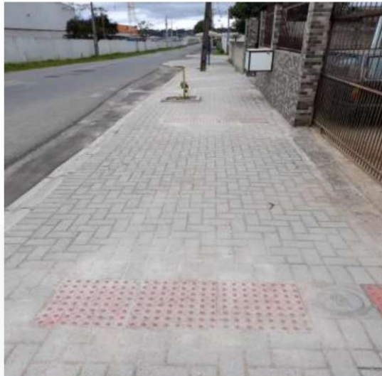
Figura 11 – Guia elevada em canteiro de árvore e piso tátil de alerta acesso de veículo, localizados na Rua Henrique Gonzaga de Souza Neto. Fonte: próprio Autor, 2022.
