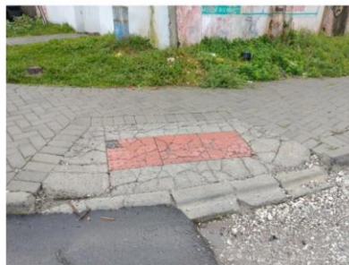
Figura 2: Rampa de acesso
