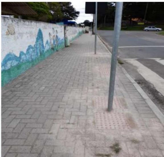
Foto 14 – Piso tátil de alerta em placa, localizado na Rua Henrique Gonzaga de Souza Neto. Fonte: próprio Autor, 2022.
