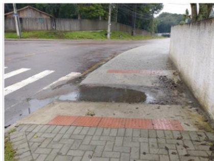
Figura 4: Rampa de acesso
