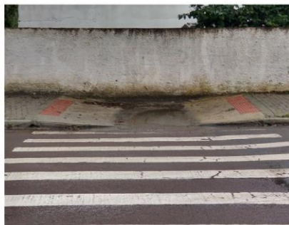
Figura 3: Rampa de acesso
