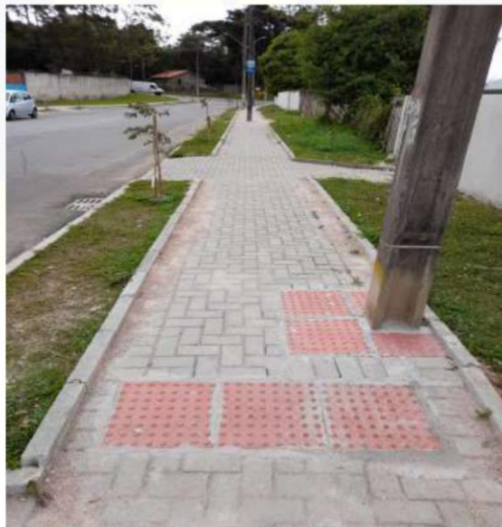
Foto 19 – Piso tátil em Poste, guias elevadas e acesso veicular, localizado na rua Ilo Antoninho Mozer. Fonte: próprio Autor, 2022.
