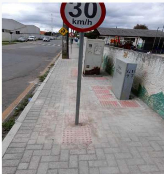
Foto 13 - Piso tátil de alerta em placa localizado na Rua Henrique Gonzaga de Souza Neto. Fonte: próprio Autor, 2022
