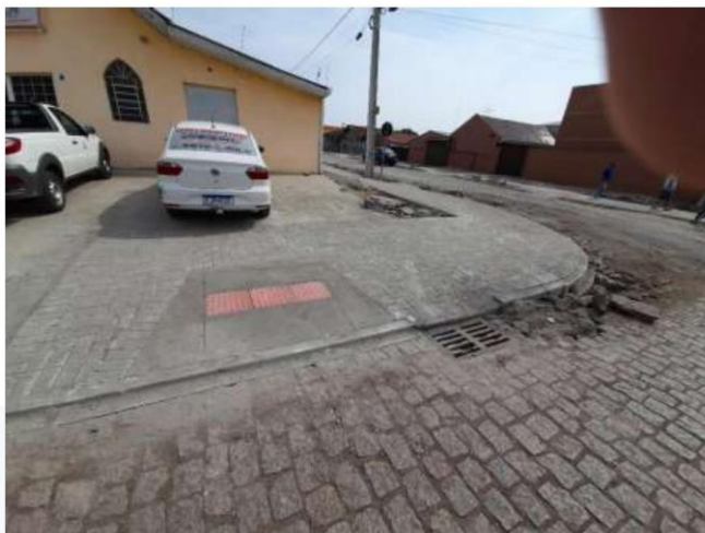
Figura 03 – Rampa de acessibilidade na esquina das ruas Antonio Sitone e Dep. Luis Gabriel Sampaio. Fonte: próprio Autor, 2022.
