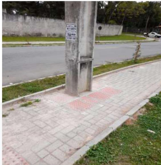
Foto 18 – Piso tátil de alerta em poste, localizado na rua Ilo Antoninho Mozer. Fonte: próprio Autor, 2022.
