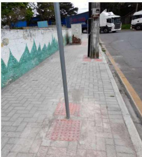
Foto 15 – Piso tátil de alerta em placa, localizado na Rua Henrique Gonzaga de Souza Neto. Fonte: próprio Autor, 2022.
