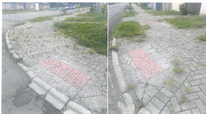
Figura 1: Rampas de acesso
