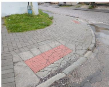
Figura 1: Rampa de acesso
