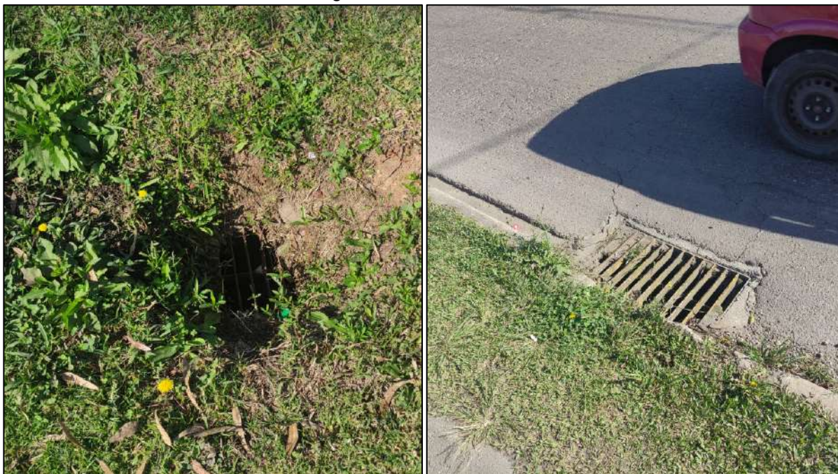
Figura 35. Bocas de lobo.
