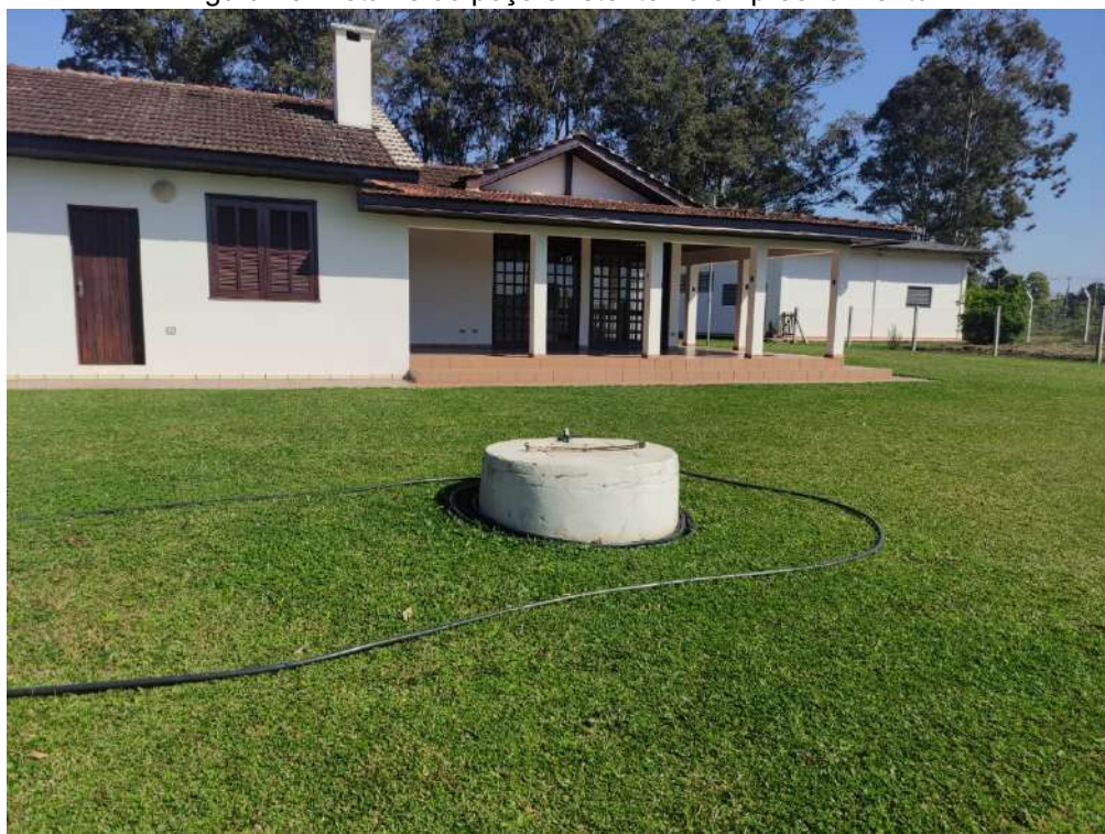
Figura 43. Detalhe do poço existente no empreendimento.
