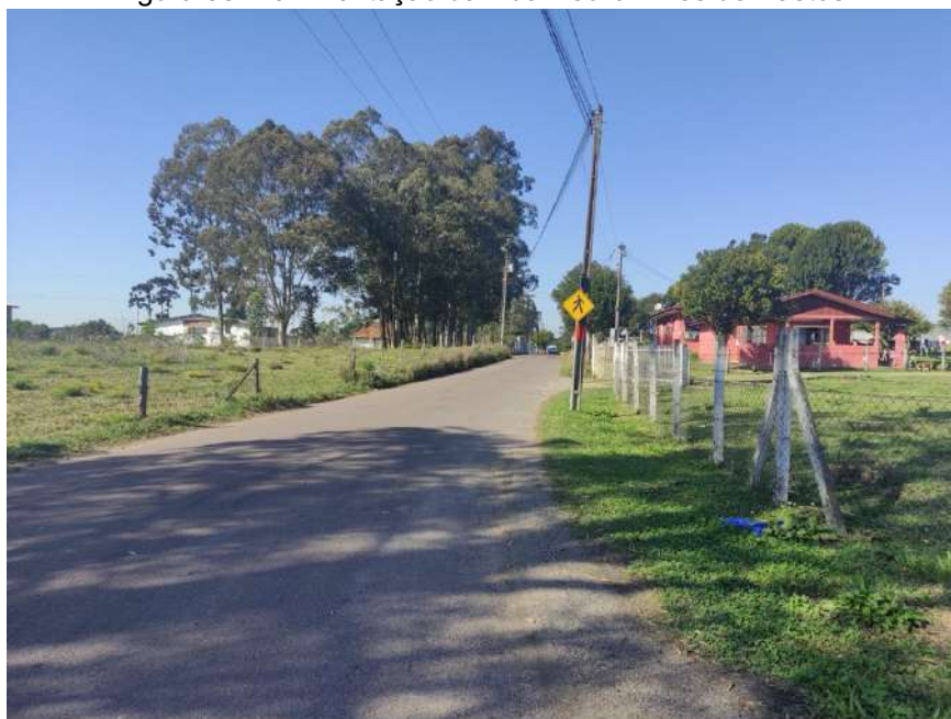
Figura 58. Pavimentação da Rua Pedro Alves de Bastos.
