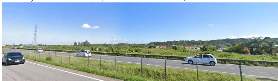
Figura 8. Testada do terreno para a Rodovia Federal BR-277, na lat. direita, ano de 2022
