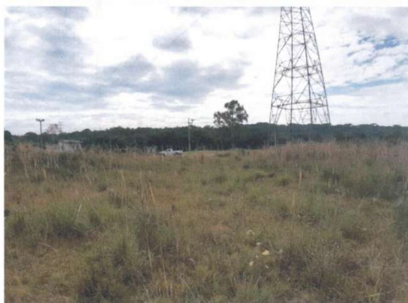
No imóvel tem sistema de alta tensão.
