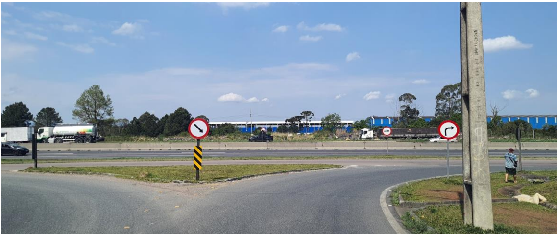
Figura 28. BR116 – Contorno Leste – acesso pela Rua Preciliano Fernandes.
