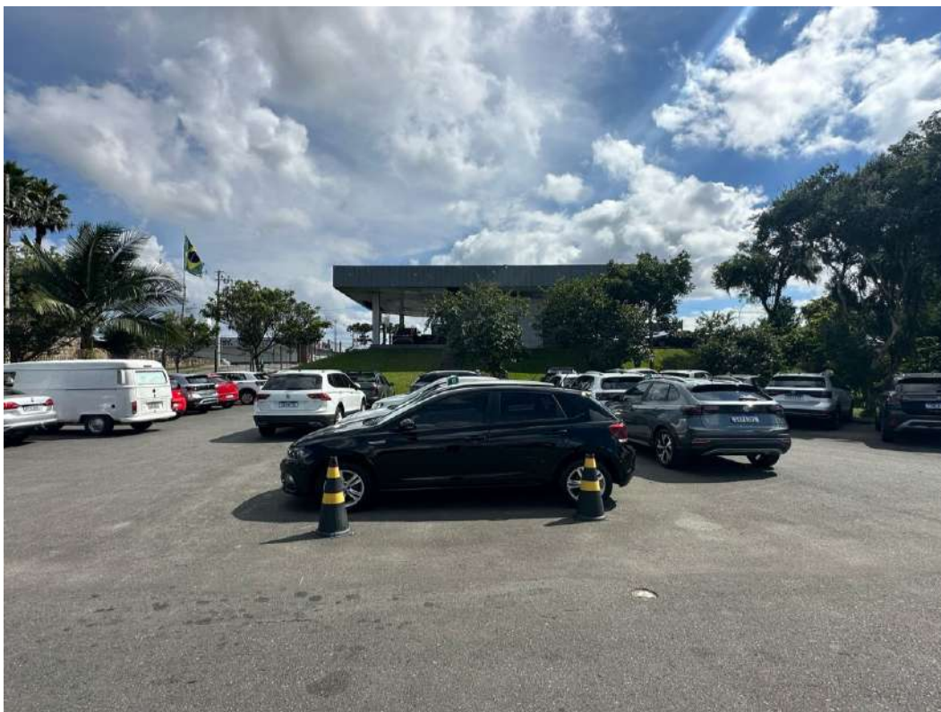
Figura 10, Vista da fachada posterior do imóvel
