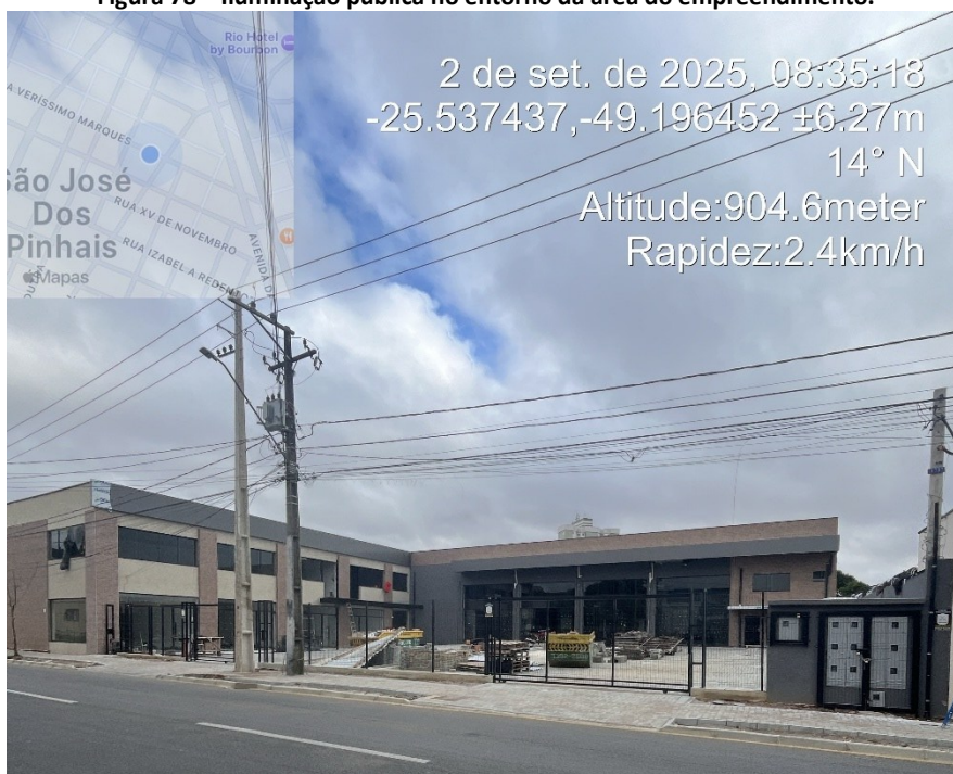
Figura 78 – Iluminação pública no entorno da área do empreendimento.
