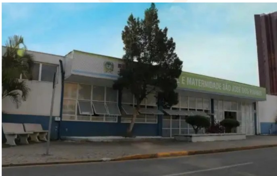
Figura 69 – Hospital e Maternidade de São José dos Pinhais.
