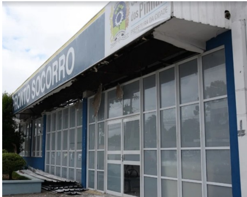
Figura 70 - Pronto Socorro de São José dos Pinhais
