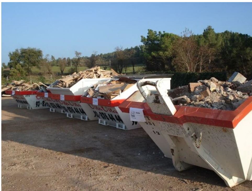
Figura 105 - Modelo de baia/caçamba para acondicionamento de resíduos.
