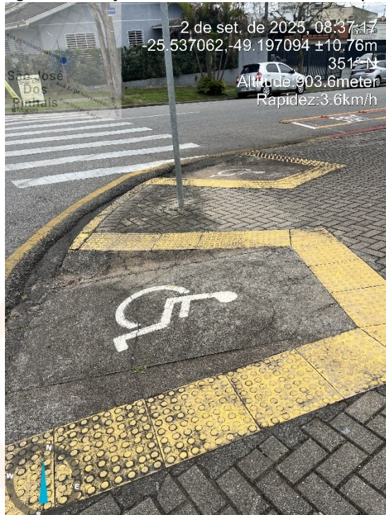
Figura 103 - Calçada rebaixada Rua Veríssimo Marques.
