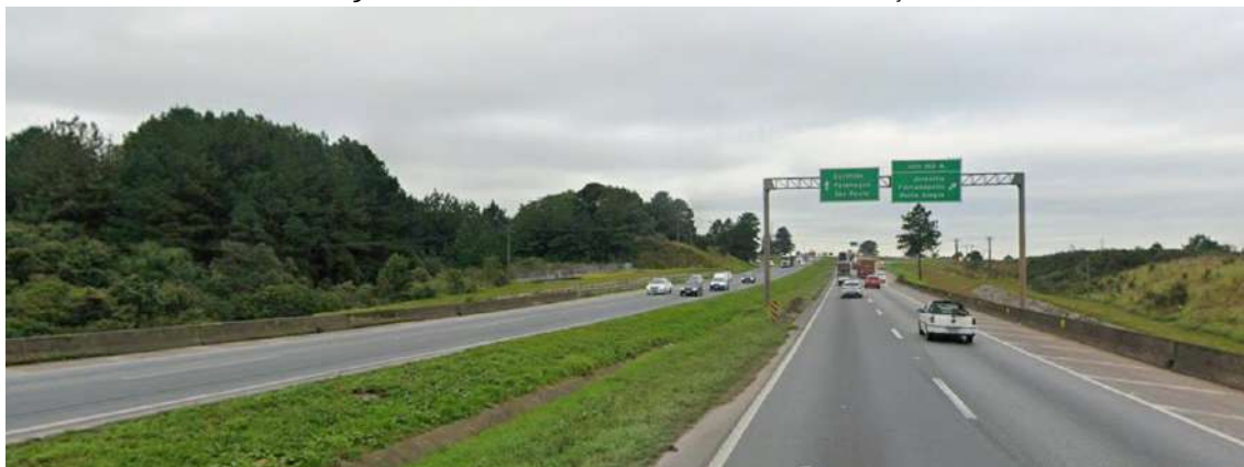
Figura 16. Rodovia Federal BR-116, via de distribuição
