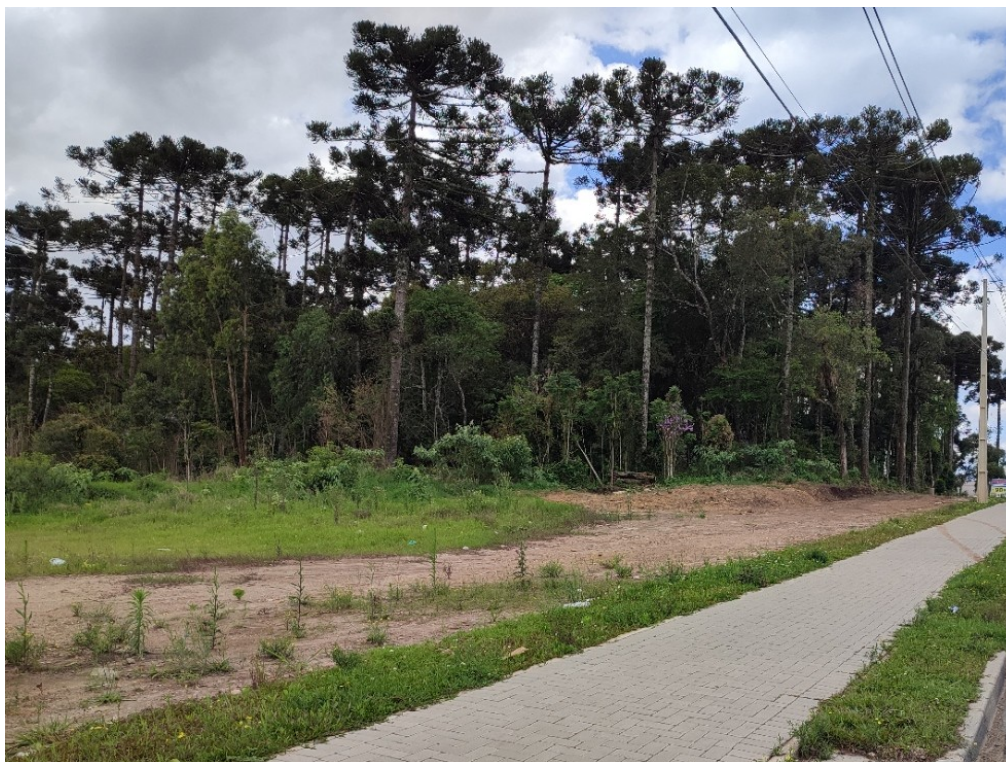
Figura 2.5. Vista a partir da Avenida Rui Barbosa para a parte frontal esquerda do lote, com infraestrutura de galerias pluviais – parte da mata a ser preservada
