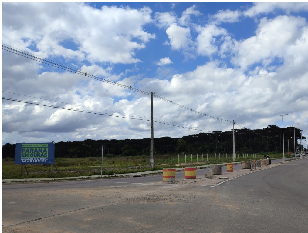
Figura 2.3. Avenida Rui Barbosa na frente do lote – rua com revestimento tipo Asfalto no cruzamento com a Rua Laerte Fenelon, com infraestrutura para pedestres.
