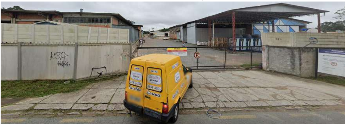
Figura 13. Acesso secundário existente pela R. Ave do Paraíso
