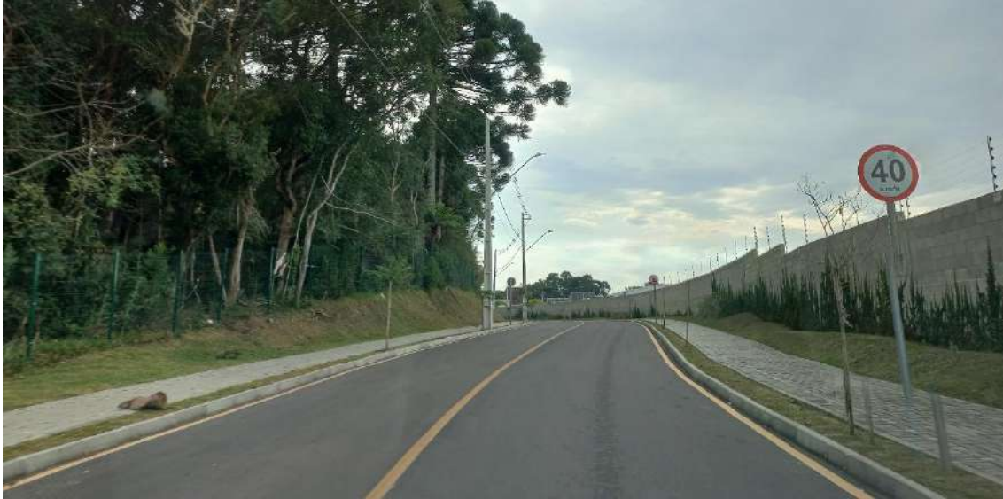
Figura 28. Avenida dos Cardeais, no trecho recém implantado e próximo aos empreendimentos
