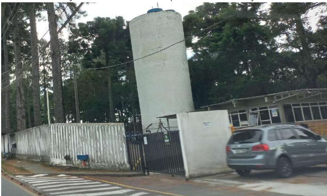
Figura 10. Acesso atual aos imóveis pela R. Maria Isabel Zen Zagonel
