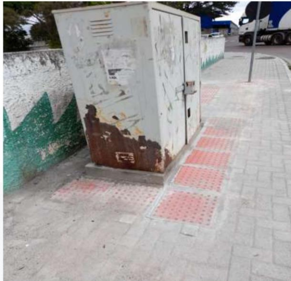
Foto 16 – Piso tátil de alerta em obstáculo, localizado na Rua Henrique Gonzaga de Souza Neto. Fonte: próprio Autor, 2022.
