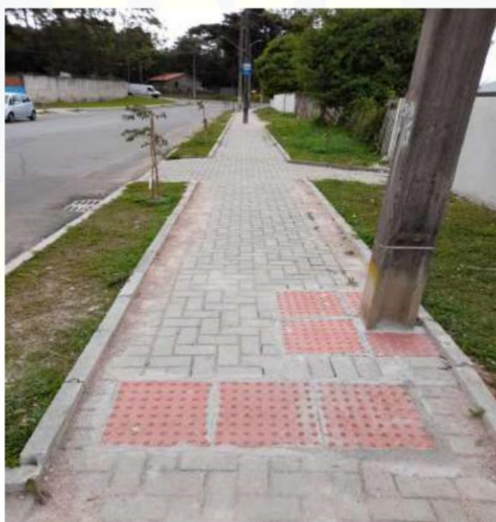
Foto 19 – Piso tátil em Poste, guias elevadas e acesso veicular, localizado na rua Ilo Antoninho Mozer. Fonte: próprio Autor, 2022.
