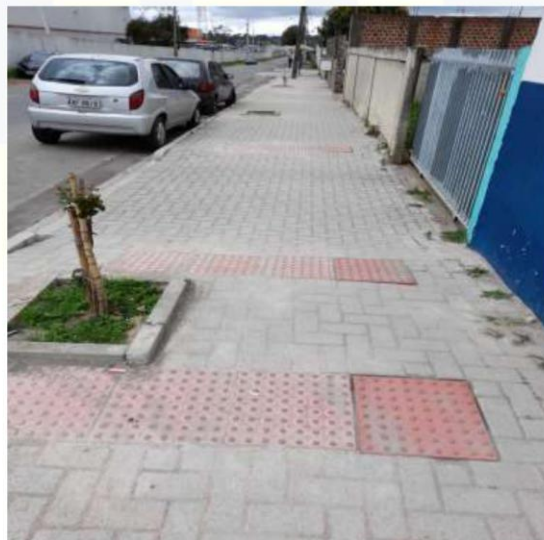
Figura 10 – Guia elevada em canteiros de árvores e piso tátil de alerta acesso de veículo, localizados na Rua Henrique Gonzaga de Souza Neto. Fonte: próprio Autor, 2022.
