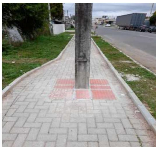
Foto 22 – Piso tátil de alerta em poste, localizado na rua Ilo Antoninho Mozer. Fonte: próprio Autor, 2022.
