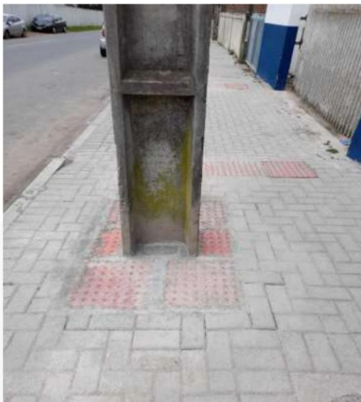
Figura 07 – Piso tátil de alerta no poste e acessos de veículos, localizados na Rua Henrique Gonzaga de Souza Neto. Fonte: próprio Autor, 2022.
