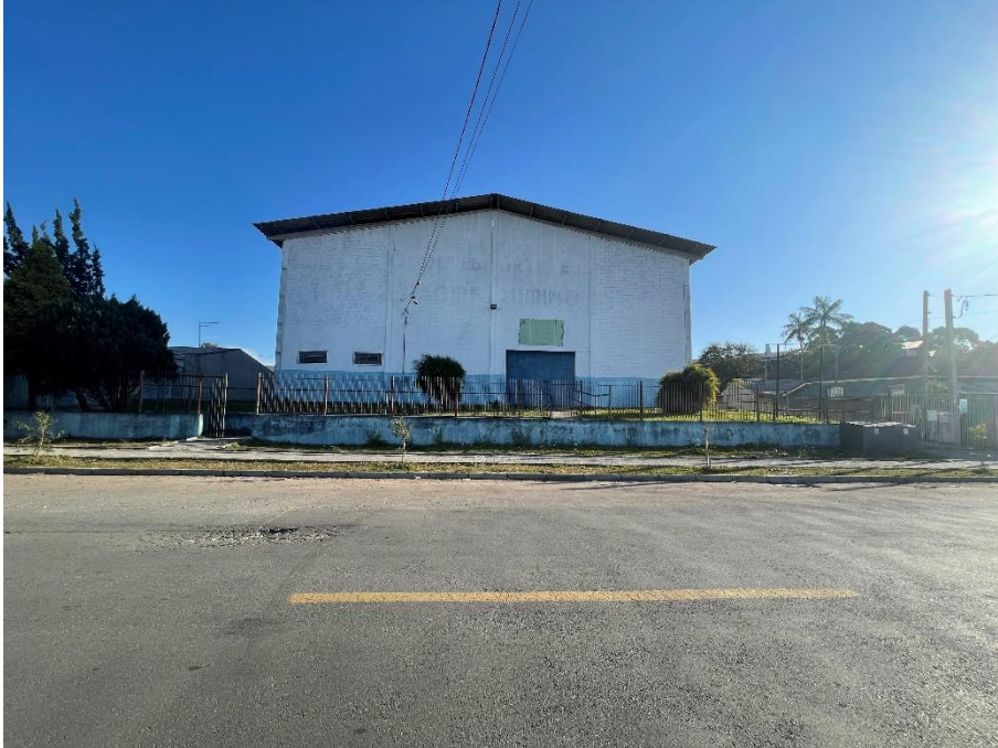
Fonte: Leal Ribas Arquitetura e Engenharia (2023).
