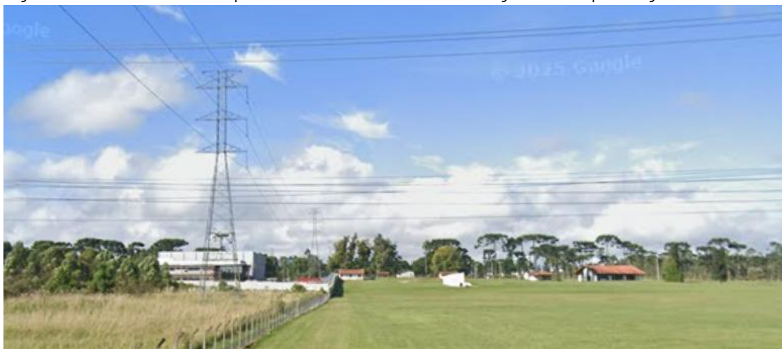
Figura 15. Torre de alta tensão para a linha de transmissão de energia elétrica que atinge o imóvel a leste
