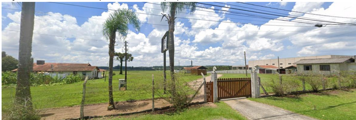
Figura 13. Acesso e construções existentes na porção sul do terreno, com frente para a Est. da Roseira
