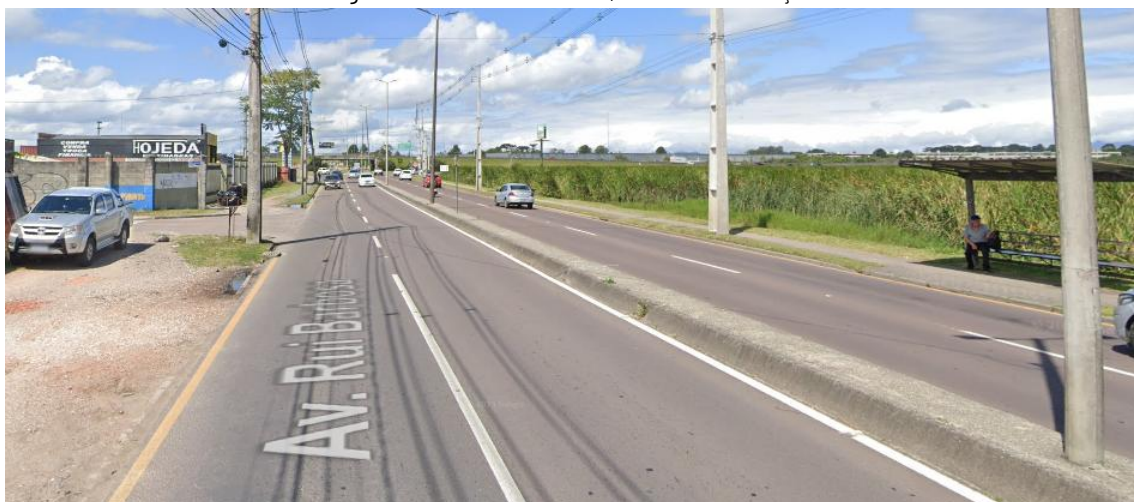
Figura 26. Av. Rui Barbosa, via de distribuição
