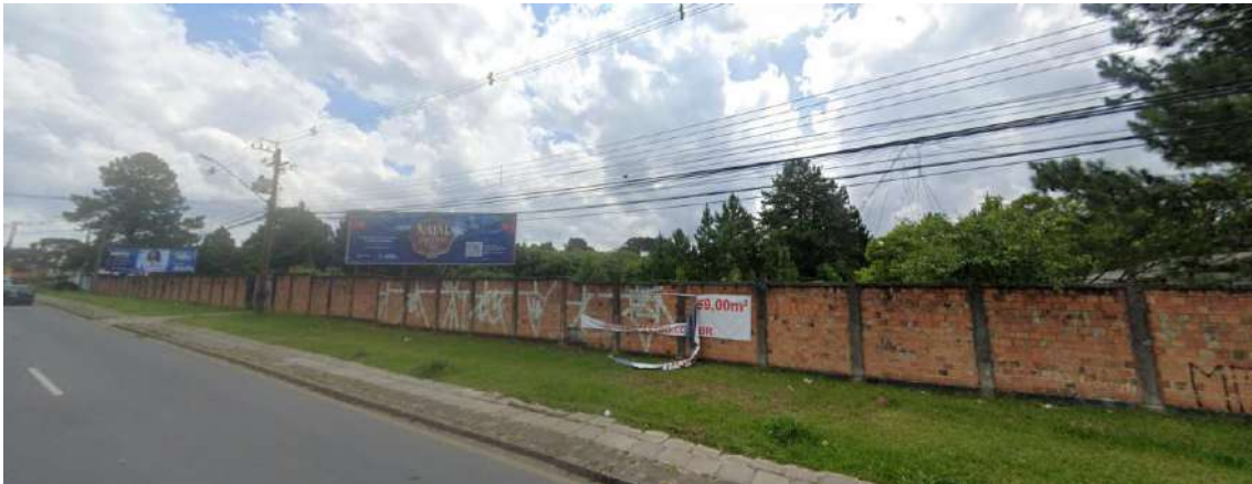
Figura 8. Testada do terreno com frente para a R. Tenente Djalma Dutra
