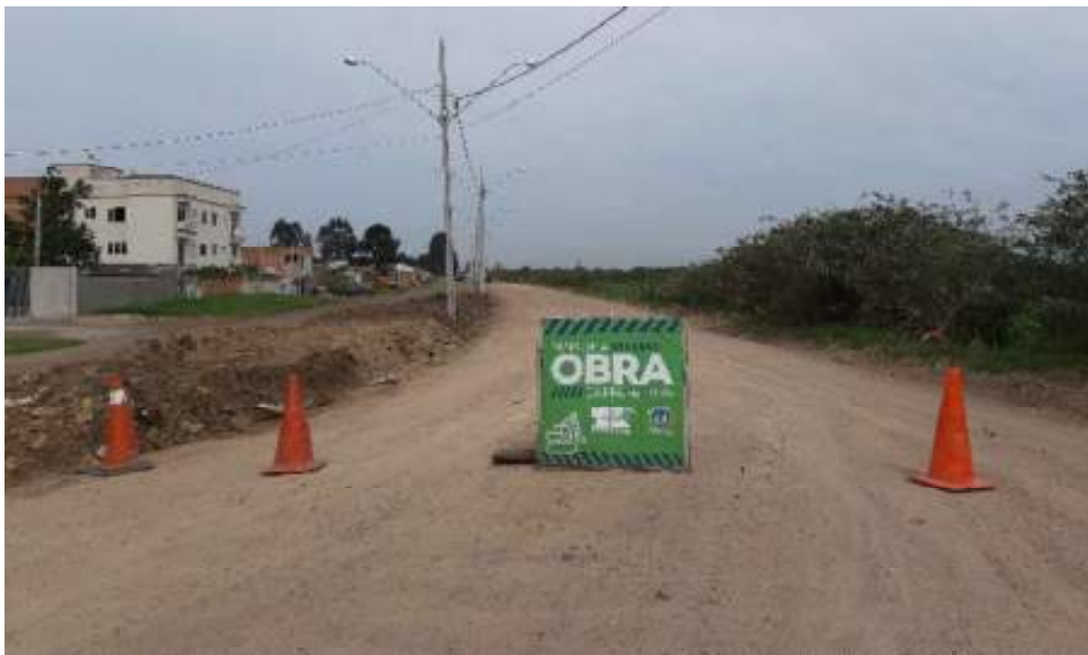
Figura 39 - Obras de revitalização da Avenida Paul Leproute – Na Fase de Obras Fonte: O Autor, 2020.
