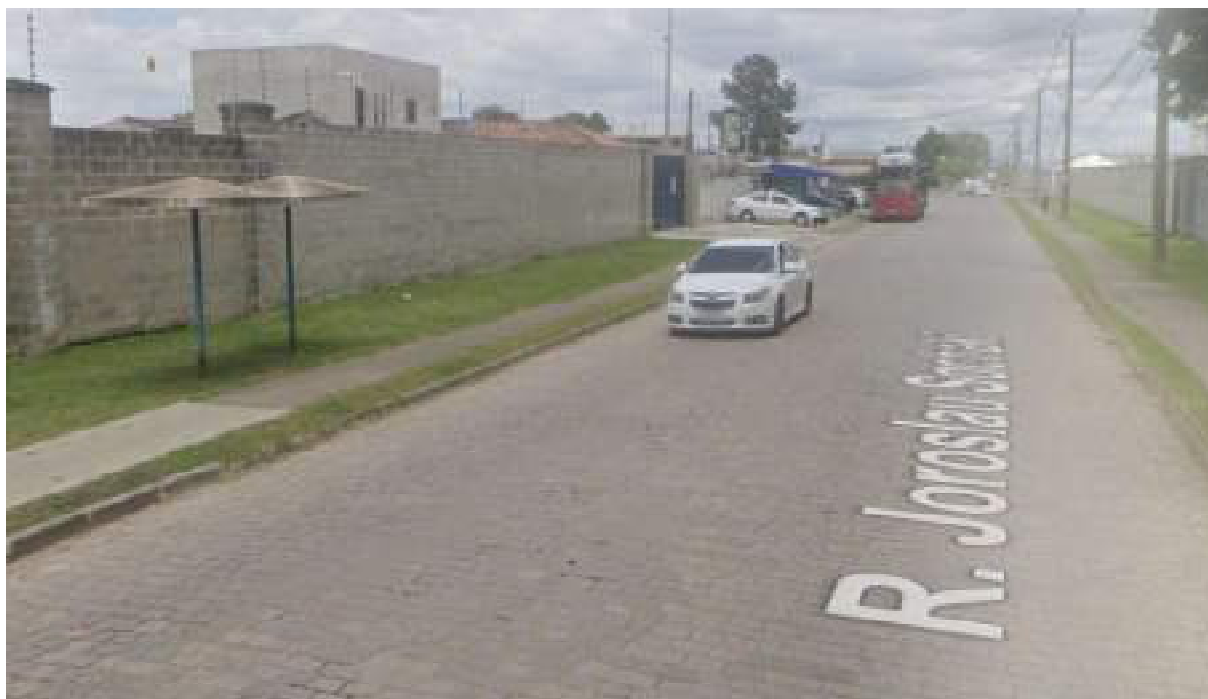
Figura 43 - Ponto de ônibus, a 480 metros do Empreendimento (Rua Joroslau Sochaki, 840).
