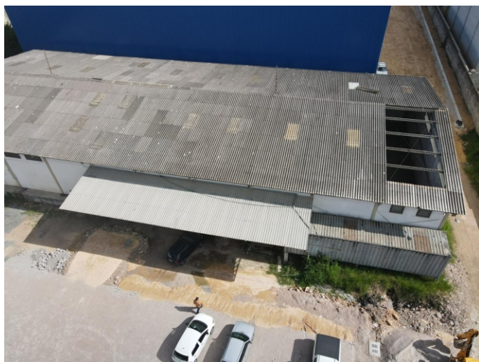
Foto 01 - Desmontagem edificação existente
