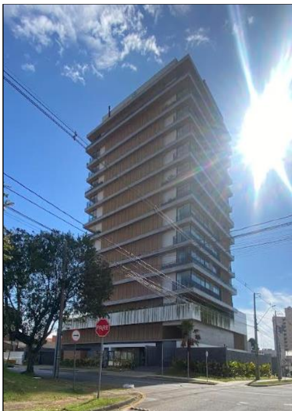
Figura 40: Fachada do Rio Maggiore Residence (14 pavtos).
