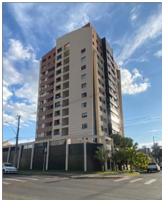
Figura 32: Fachada do Edifício Siqueira Cortes (14 pavtos).
