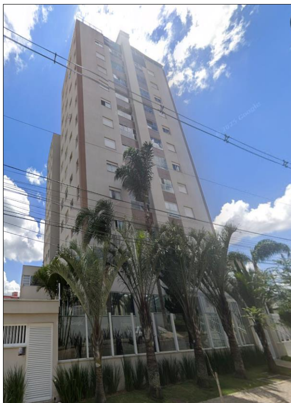
Figura 35: Fachada do Edifício San Diego com 11 pavimentos.
