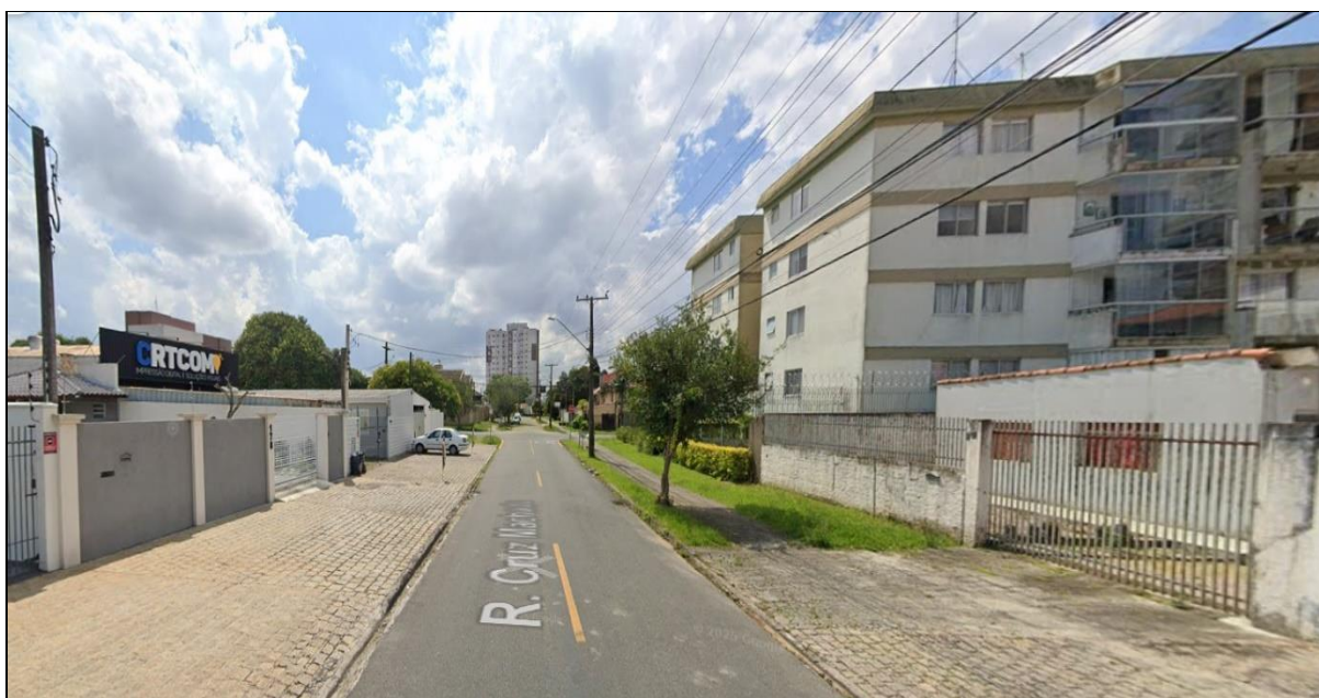
Figura 45: Elevação de comércio e edifício residencial situados na Rua Cruz Machado.
