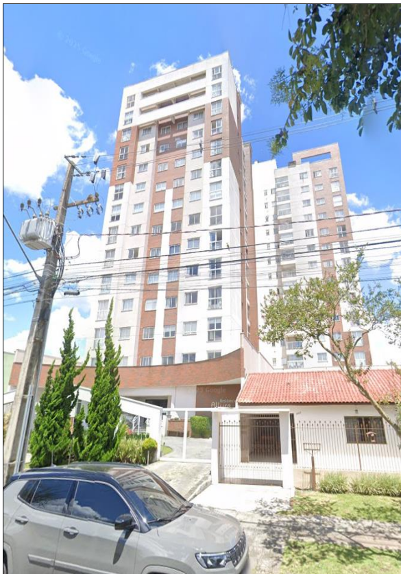
Figura 38: Fachada do Edifício Allure (14 pavtos).
