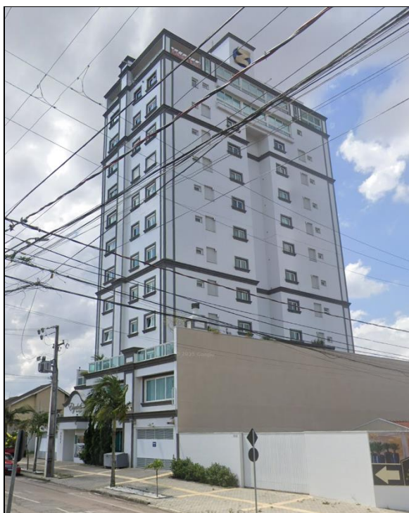
Figura 36: Fachada do Edifício Elizabeth (14 pavtos).
