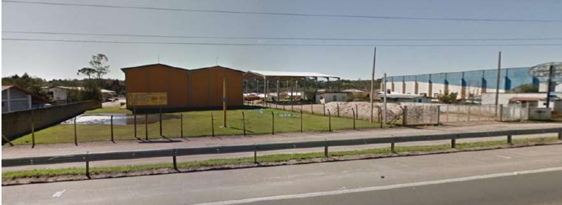
Figura 8. Testada do imóvel com frente para a via marginal da Rod. Federal BR-277, ano de 2011
