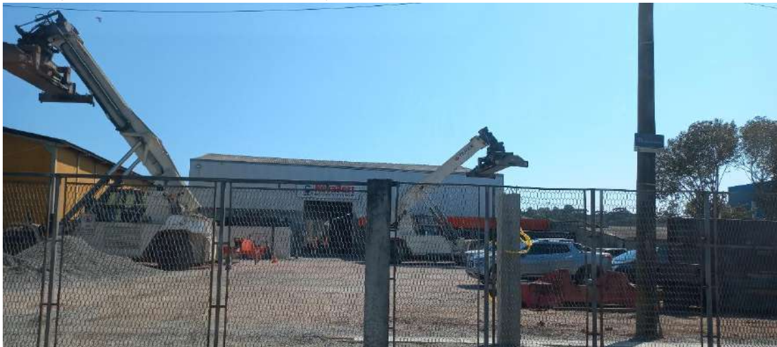
Figura 12. Frente do imóvel com vista para a lateral direita, observado da Rod. Federal BR-277
