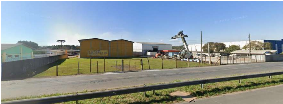
Figura 9. Testada do imóvel com frente para a via marginal da Rod. Federal BR-277, ano de 2023
