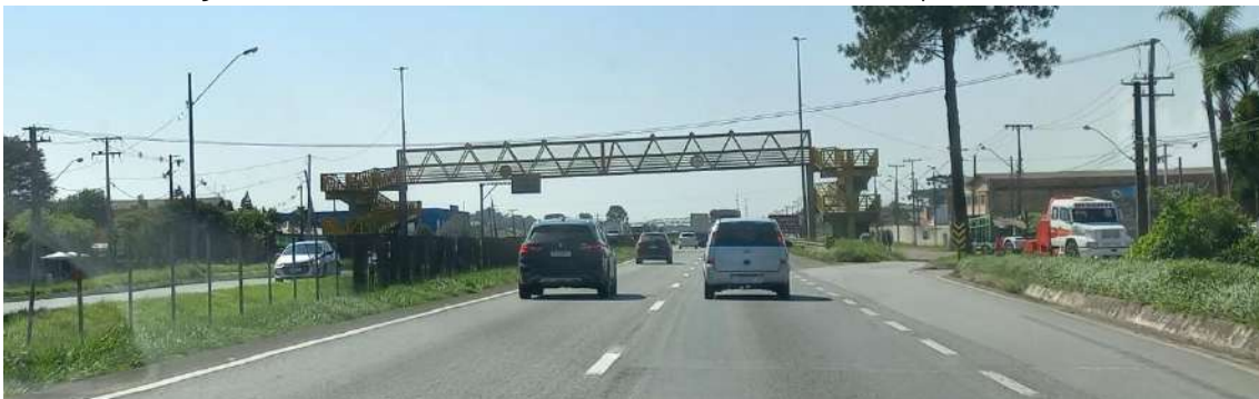
Figura 23. Rodovia Federal BR-277, em trecho defronte ao empreendimento
