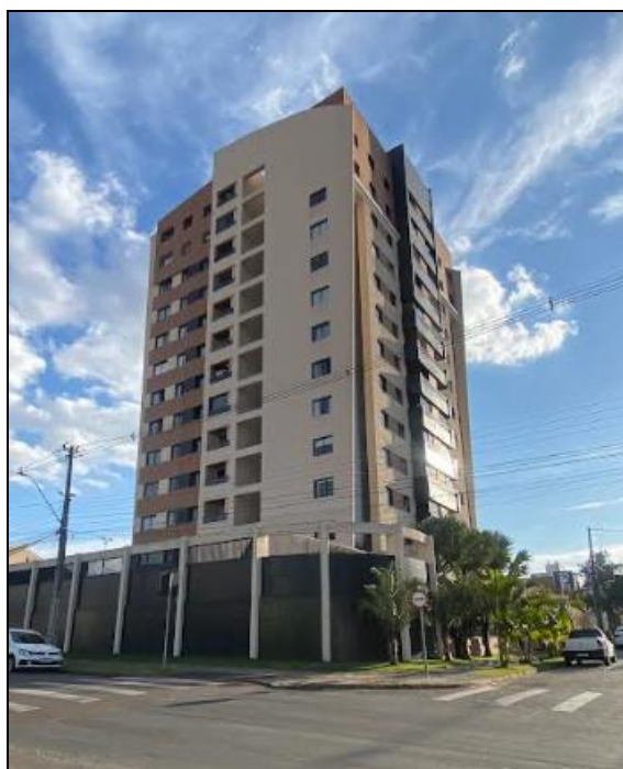
Figura 30: Fachada do Edifício Siqueira Cortes (14 pavtos).
