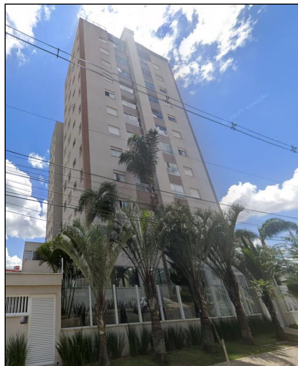
Figura 33: Fachada do Edifício San Diego com 11 pavimentos.
