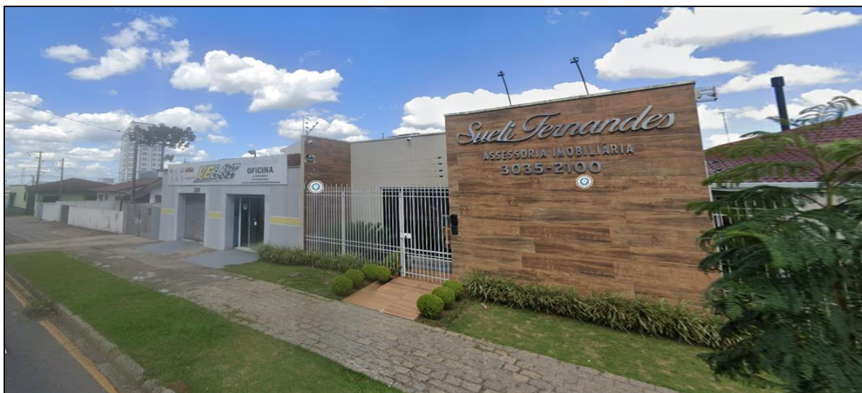
Figura 42: Elevação de alguns comércios e serviços no entorno do novo Empreendimento.
