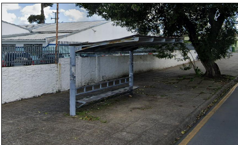
Figura 47: Ponto de ônibus implantado na Rua Profª Jorge Mansos do Nascimento Teixeira, distante aproximadamente 186,00m do novo Condomínio.
