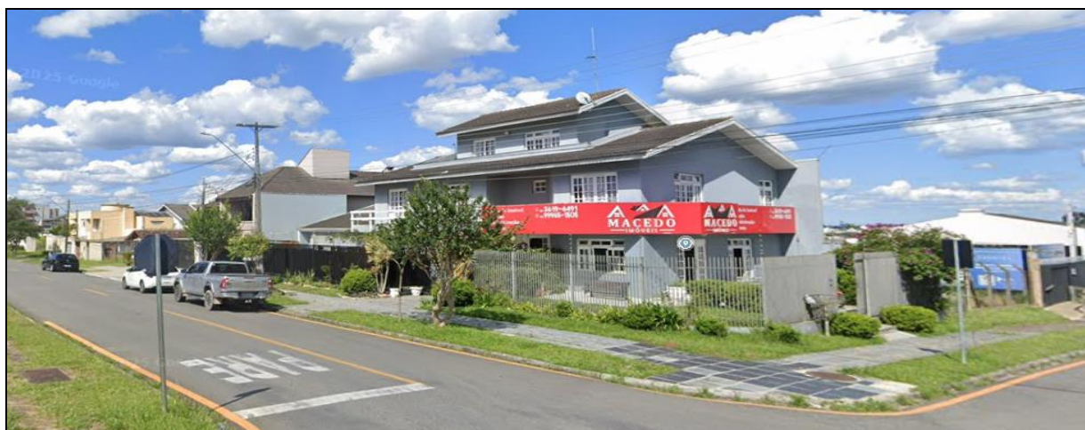
Figura 41: Vista de Edificações residenciais que mudaram o uso para comercio e serviço permitidos pela zona ZC2, localizados na mesma Rua Maria Helena.
