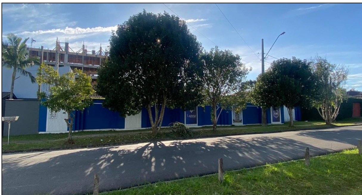
Figura 44: Fachada frontal do terreno onde será implantado o Novo Condomínio Laguna Sky Garden.
