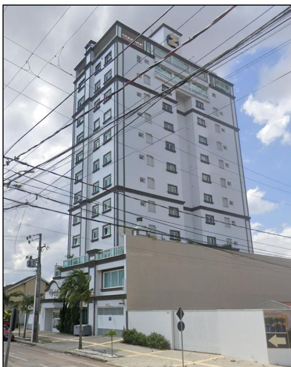
Figura 34: Fachada do Edifício Elizabeth (14 pavtos).
