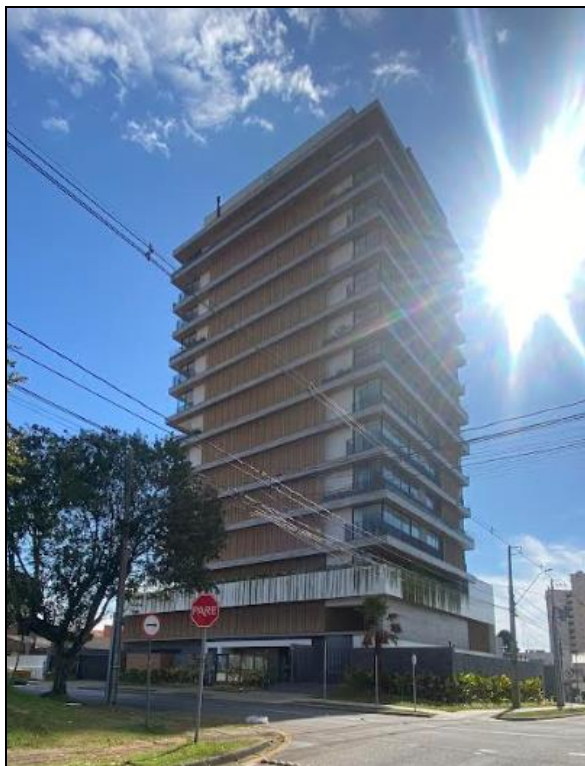
Figura 36: Fachada do Rio Maggiore Residence(14 pavtos).
