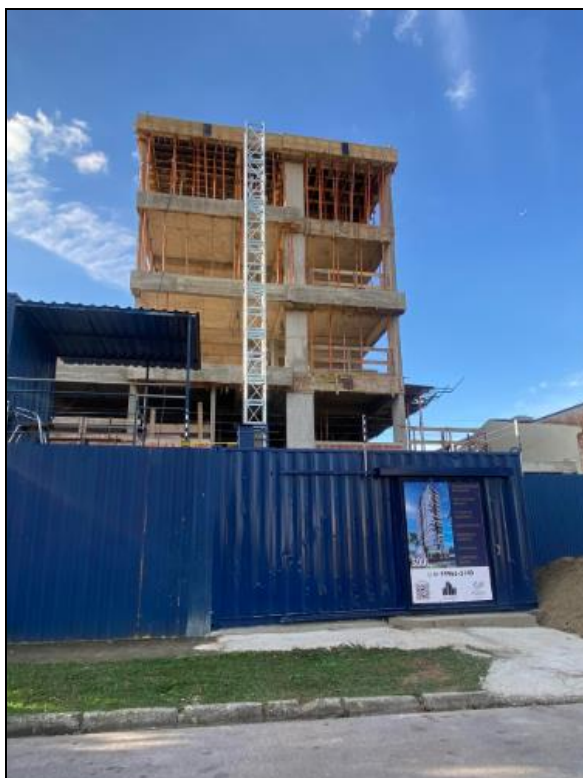
Figura 38: Elevação do Edifício Soul, localizado na mesma quadra do novo Condomínio Laguna Sky Garden.
