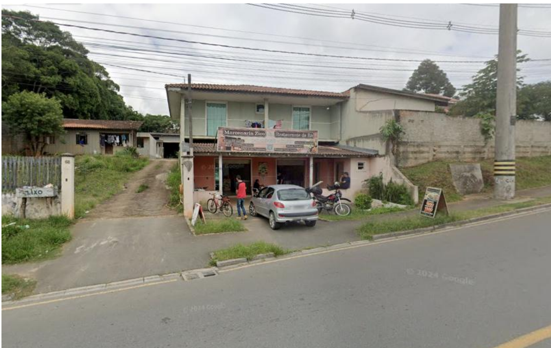
Imagem: Edificações na frente do lote do Empreendimento (Rua Antonio Molletta Filho)
