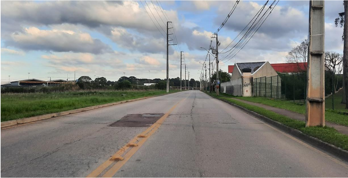
Figura 24. Avenida Industrial, acesso ao lote do empreendimento
