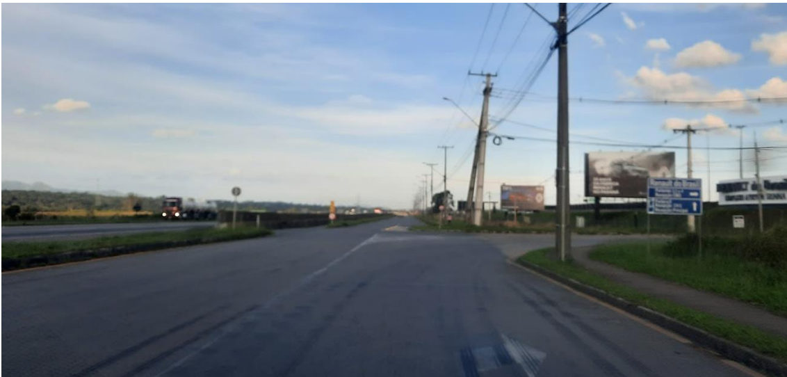
Figura 27. Acesso à Avenida Industrial – vias marginal BR 277
