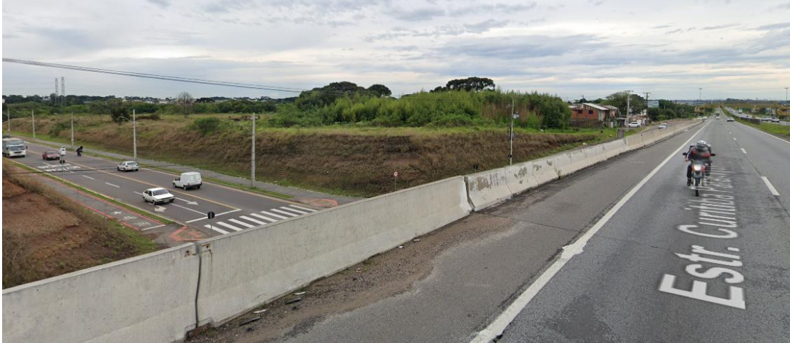
Figura 25. Trincheira entre a R. Marechal Hermes e a Rod. Federal BR-277, vias de distribuição
