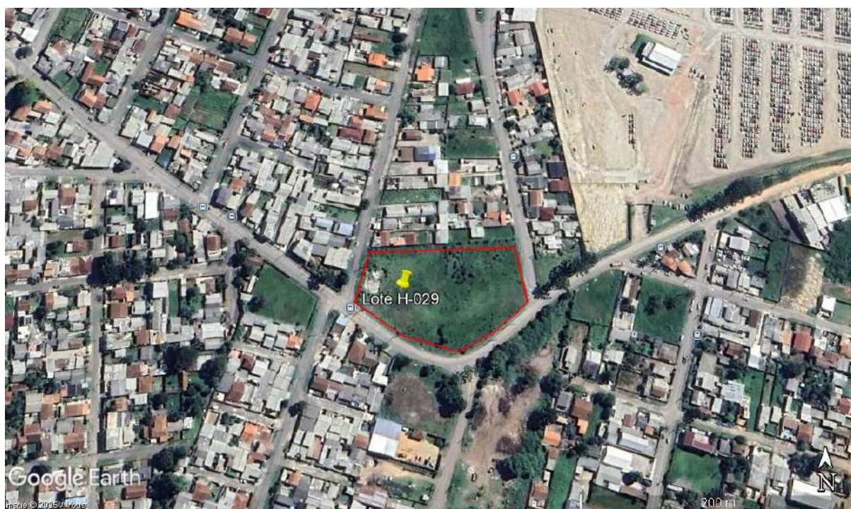
Figura 18 - Foto aérea do imóvel em 2024, fonte: Google Earth
