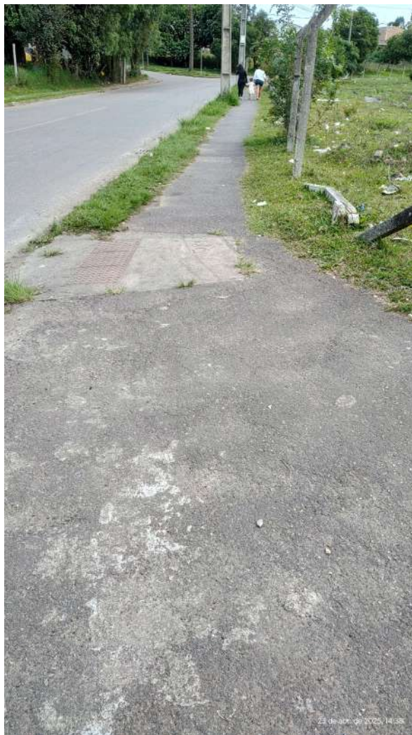
Figura 32 - Vista do calçamento, Estrada da Roseira
