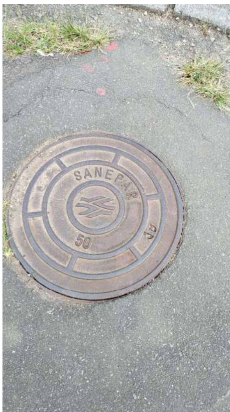
Figura 27 - Serviço de fornecimento de água tratada, Estrada da Roseira
