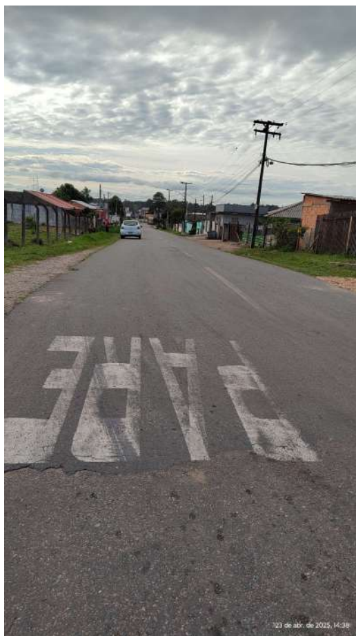
Figura 29 - Vista da pavimentação, Rua Evelize Aparecida Rosseti Mendes
