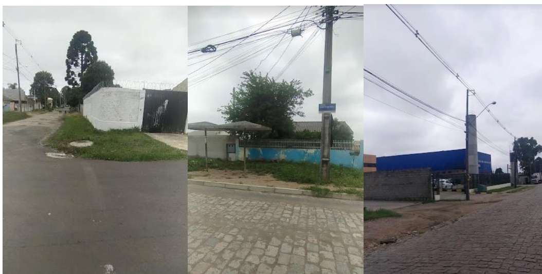
Figura 18 - Demonstração das infraestruturas de iluminação e esgotos dos entornos da área
