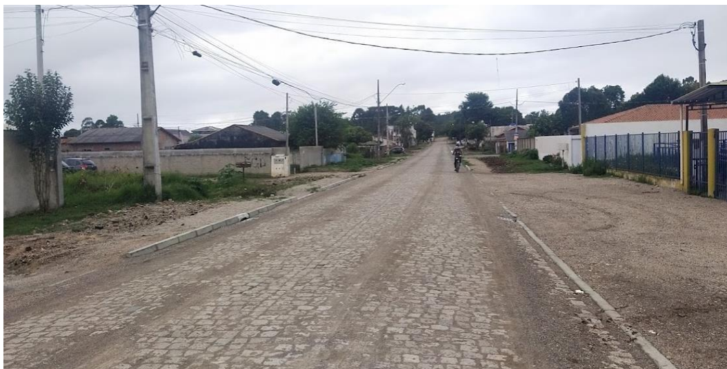
Figura 16 - Demonstração da infraestrutura das vias de acesso ao empreendimento
