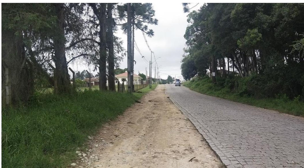
Figura 17 - Demonstração da infraestrutura das vias de acesso ao empreendimento
