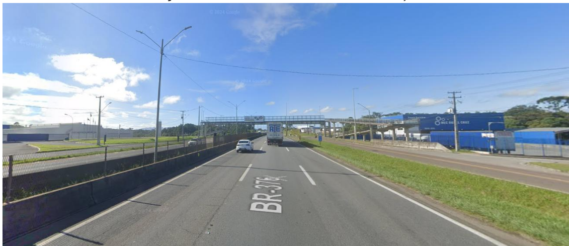
Figura 24. Rod. Federal BR-376, via de distribuição
