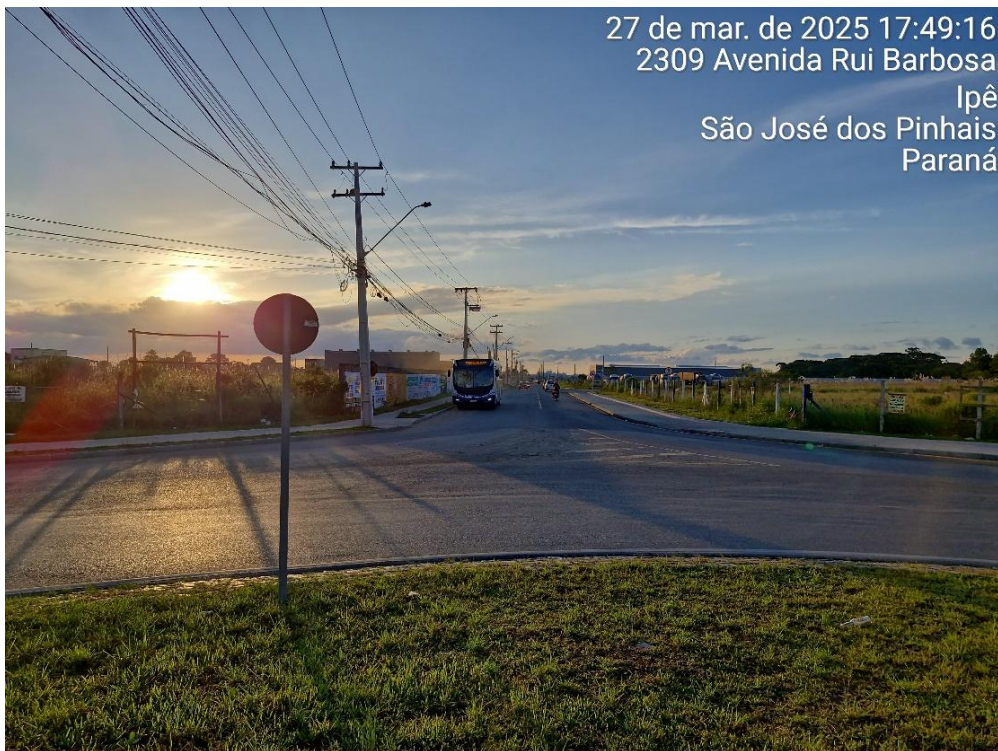
Figura 17 – Pavimentação na rua Laerte Fenelon
