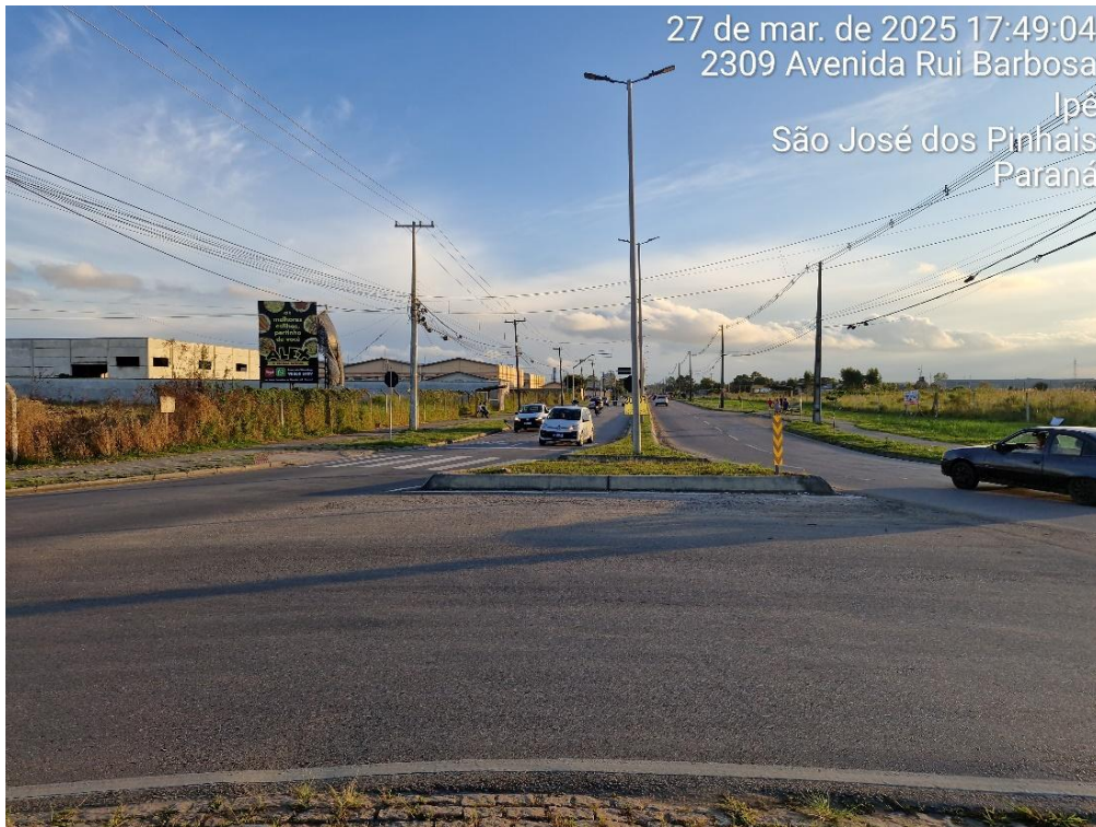
Figura 16 – Pavimentação na av. Rui Barbosa
