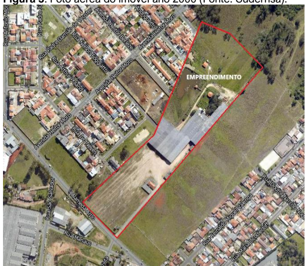
Figura 5: Foto Aérea do imóvel no ano de 2012 (Fonte:PMSJP).
