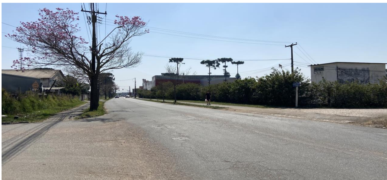
Figura 40: Vista da Alameda Arpo, em frente ao Empreendimento e próximo à esquina com a Rua Boa Vista.
