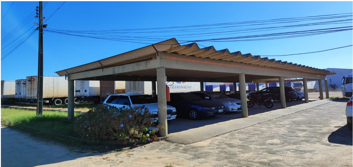
Figura 19: Vista da Garagem de veículos ao lado do Escritório.
