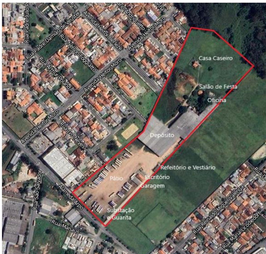
Figura 13: Vista aérea do Empreendimento com a localização das edificações existentes sobre o Lote 1-A-II.
