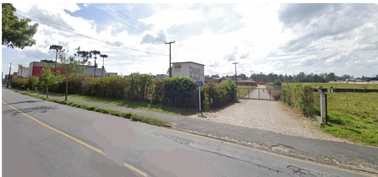
Figura 15: Vista frontal do acesso e do terreno onde está implantado o Empreendimento, contendo cerca viva de fechamento em frente a Alameda Arpo.
