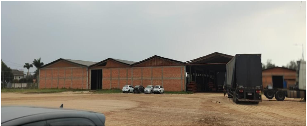
Figura 16: Vista frontal dos Barracões para Depósito e do Pátio para carga e descarga das carretas.
