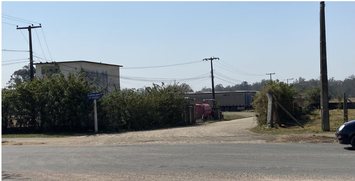
Figura 24: Vista do acesso para pedestre e veículos do Empreendimento, com área de espera e acumulação dentro do alinhamento predial.
