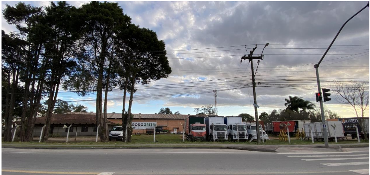
Imagem 35: Fachada frontal da Transportadora Rodogreen, situada na Rua Dr. Murici.
