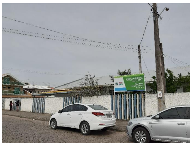
Figura 27: Escola Municipal Irmã Maria Eufrásia Torres Rua Pedro Ribaski, N° 186 – CEP: 83.055-260. <Fonte Google Maps>.
