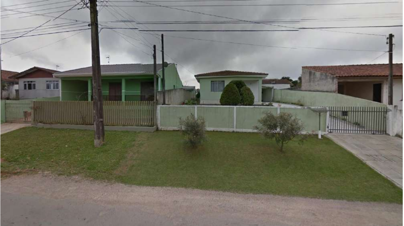
Figura 20: Habitações Unifamiliares no Entorno do Lote F-978 - Rua Jovino Dissenha.
